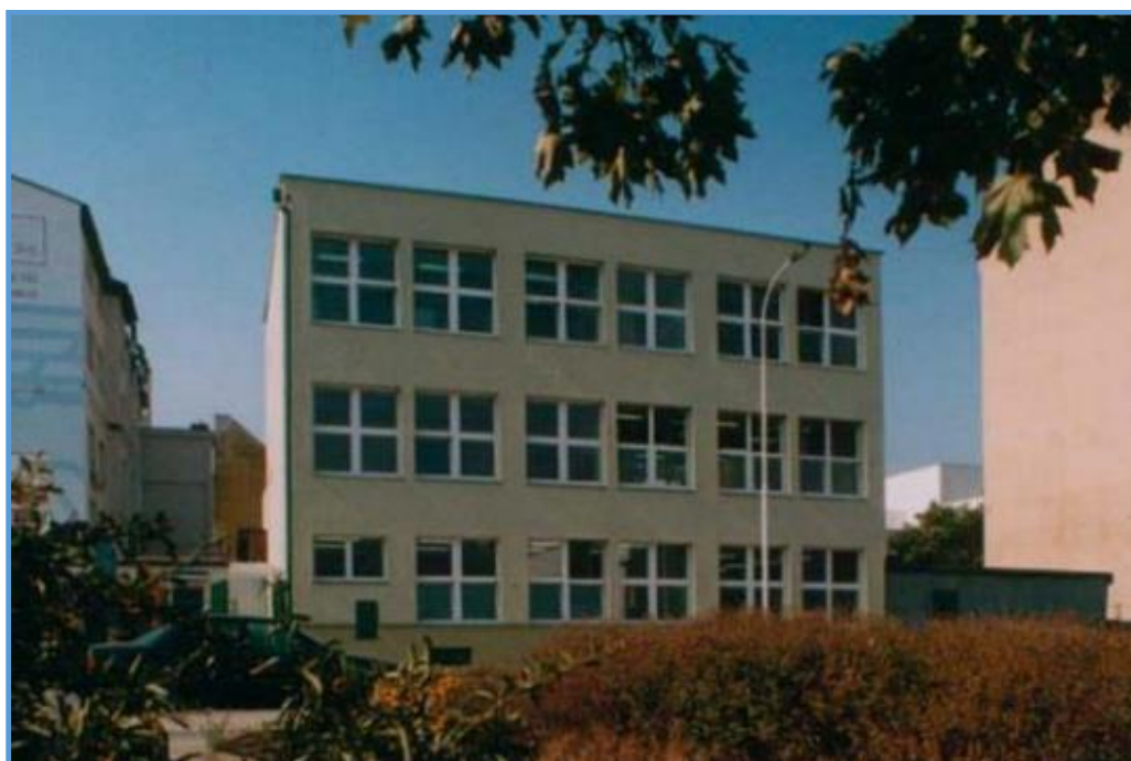
Sídlo praktické výuky SŠUAŘ, Kovářská. Zdroj: SŠUAŘ.
