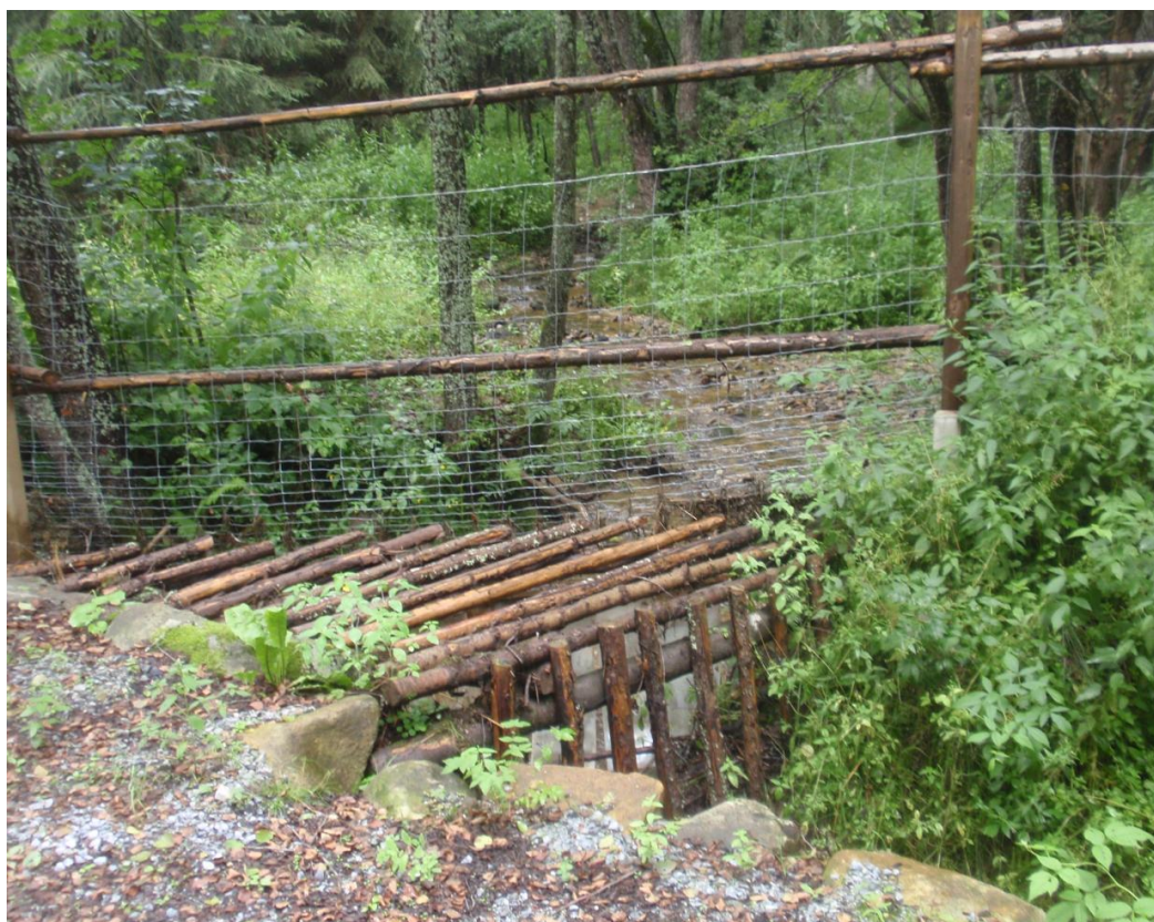
Propustek na vodoteči
