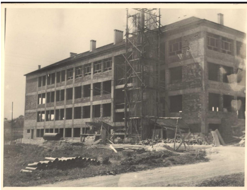
Příloha 6 - stavba nové školní budovy, cca rok 1950
