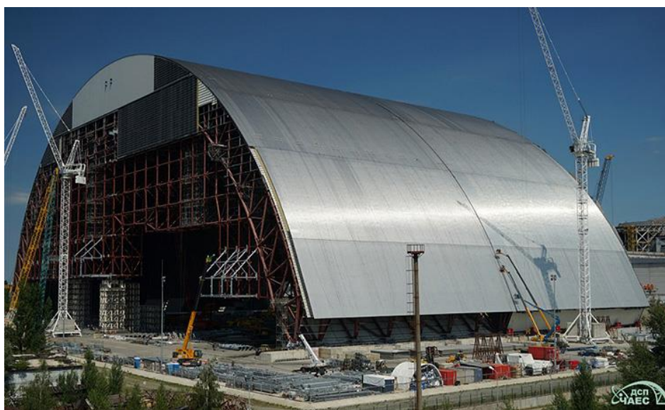
Obrázek 5: Stavba nového sarkofágu
