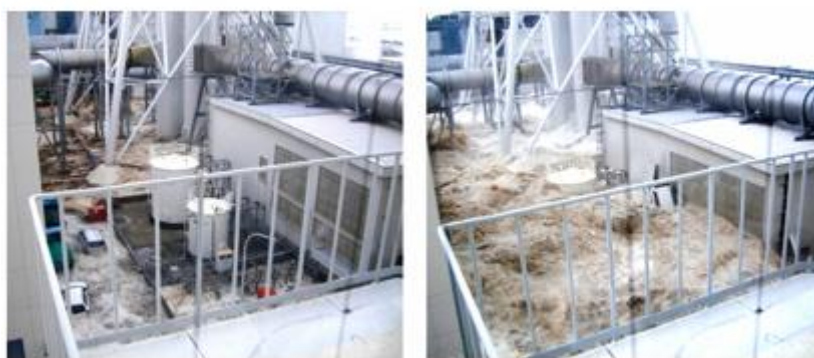
Obrázek 6: Zaplavení elektrárny vlnou tsunami
