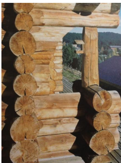
Obrázek 7 Spoj nehraněného srubu, ložné spáry s výřezem do tvaru „U“ (ŠTEFKO, 2009)
