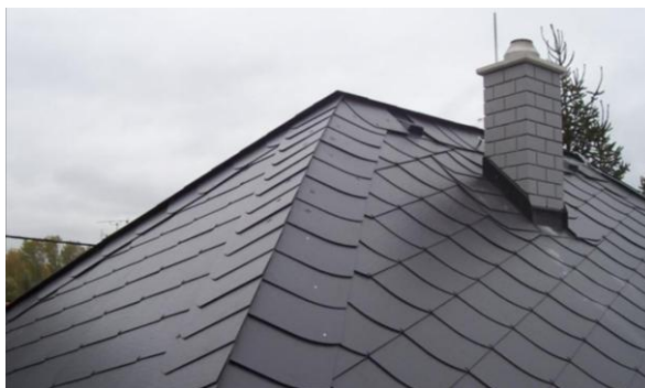
Obrázek 13 Šablona (čtverec se zkosenými rohy) vlákno-cementové krytiny (ŽAŽA, 2007)
