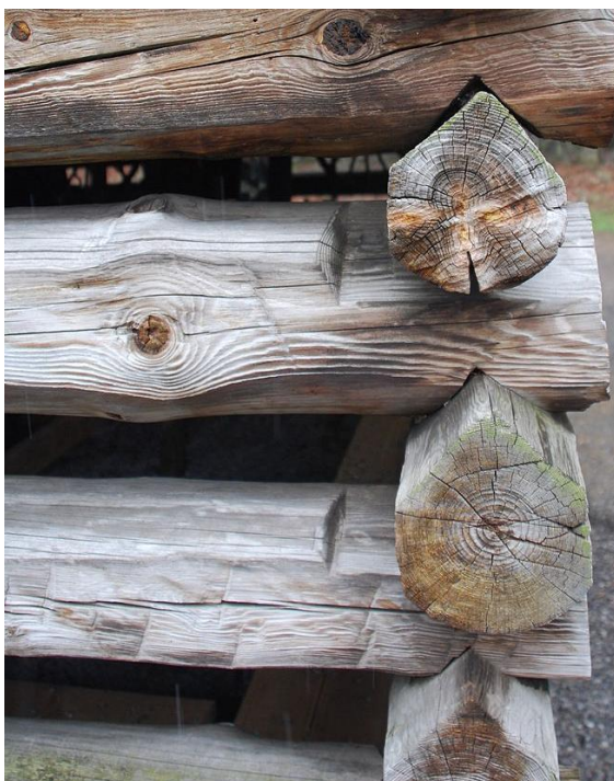
Obrázek 1 Rohový spoj-dřívější způsob (TUSZYNSKI, 2009)
