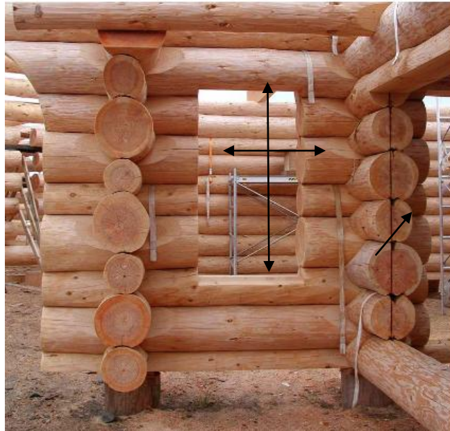
Obrázek 15 Otvory pro okno a dveře (CHAMBER, 2004)
