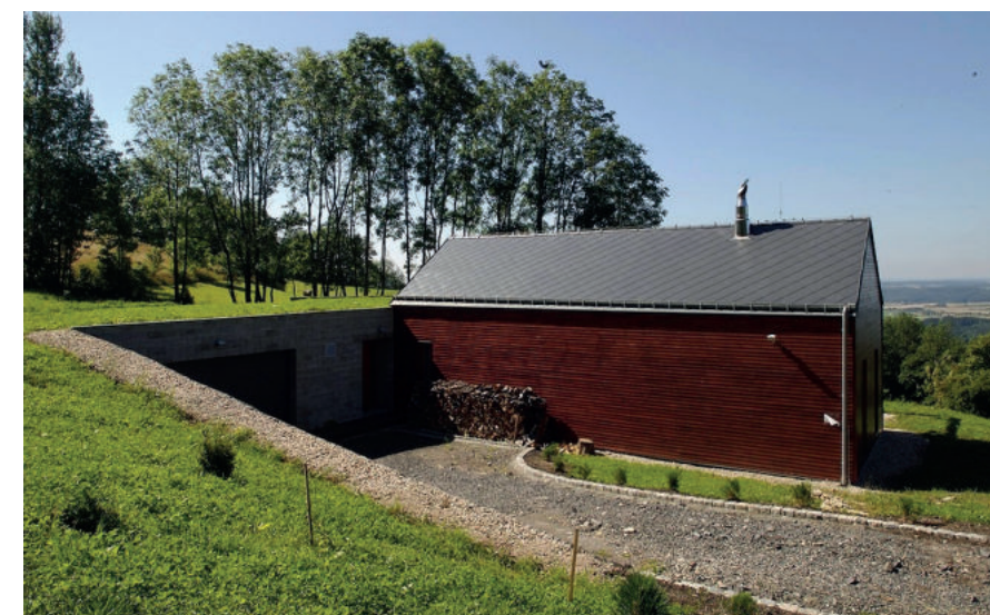
Obrázek č. 68-72: Dům na Ještědském hřebeni, zdroj: Archiweb
