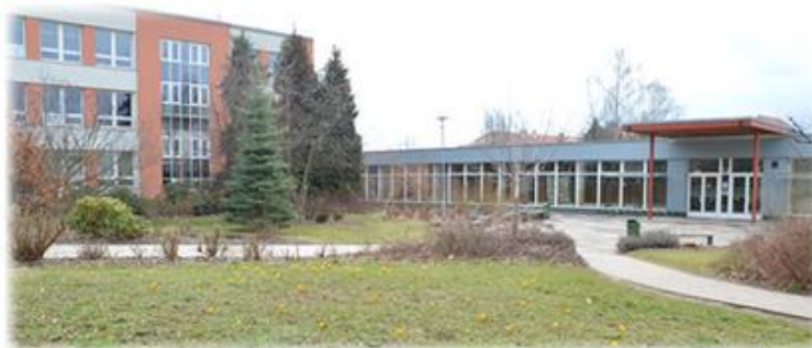
Obr.č.5- IV.ZŠ Železničářská (Zdroj: http://4zs.jicin.cz/ )
