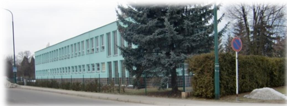
Obr.č.7- SSŠ podnikatelská Altman s.r.o (Zdroj: http://www.sposka.cz/gfx/galerie/img00032.jp )
