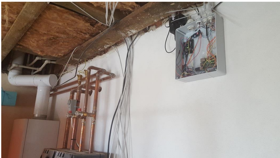
Obrázek B.1 Box, ve kterém je umístěno Raspberry Pi a další hardwarové prvky chytrého domu
