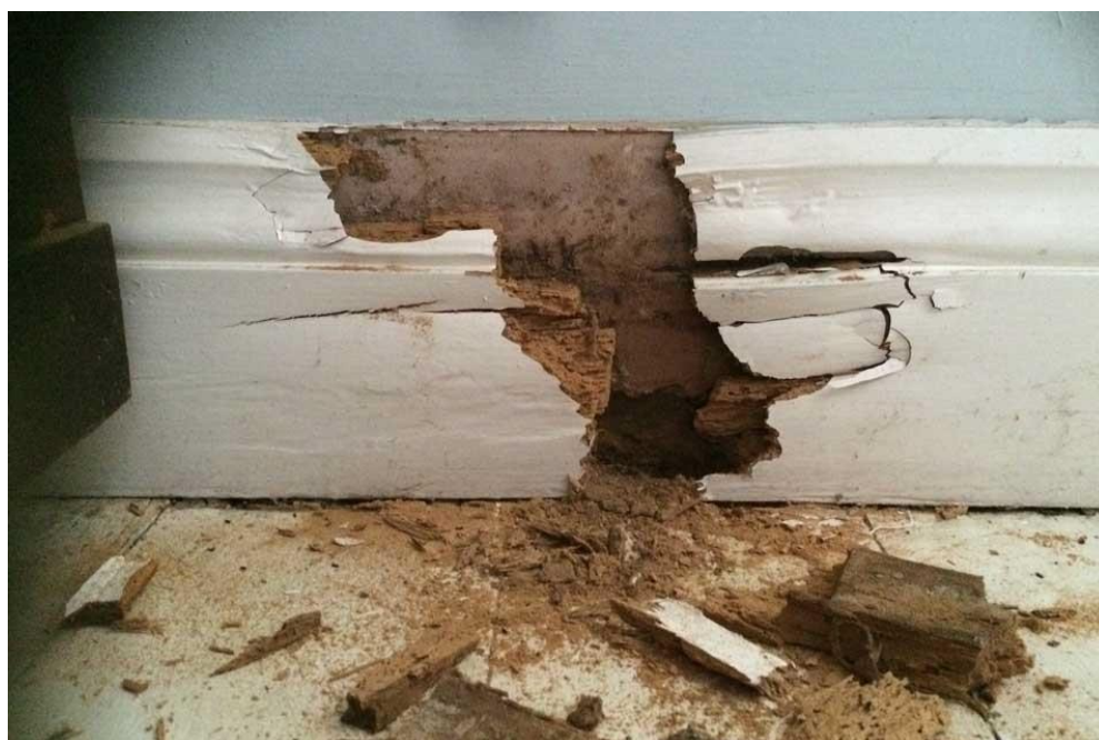
Obrázek 1: Napadení dřeva hnědou hnilobou (Property Care Association, 2024)
