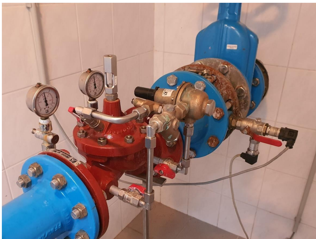
Obr. 0.1 Tlakový redukčný ventil CLA-VAL NG1E-90-01.
