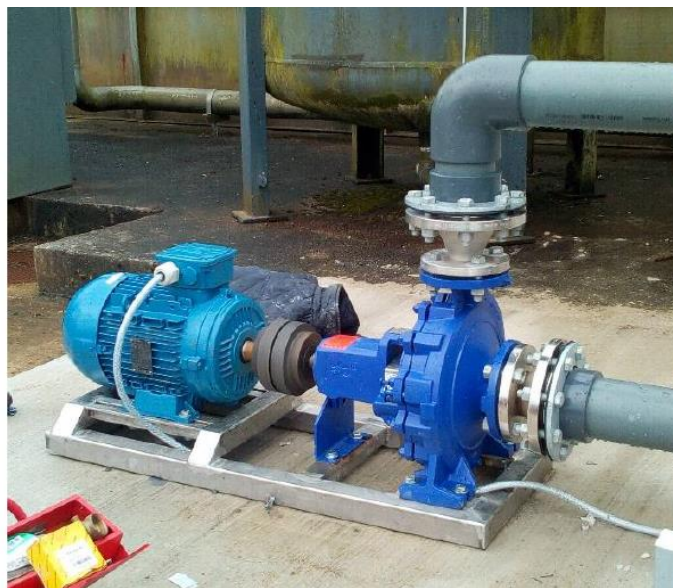
Obr. 1.1 Odstredivé čerpadlo rekuperačného systému Blackstairs GWS [3].
