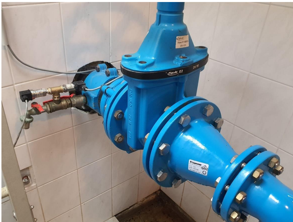
Obr. 0.3 Montážny ventil siete a tlakové senzory pre meranie experimentálnych dát.
