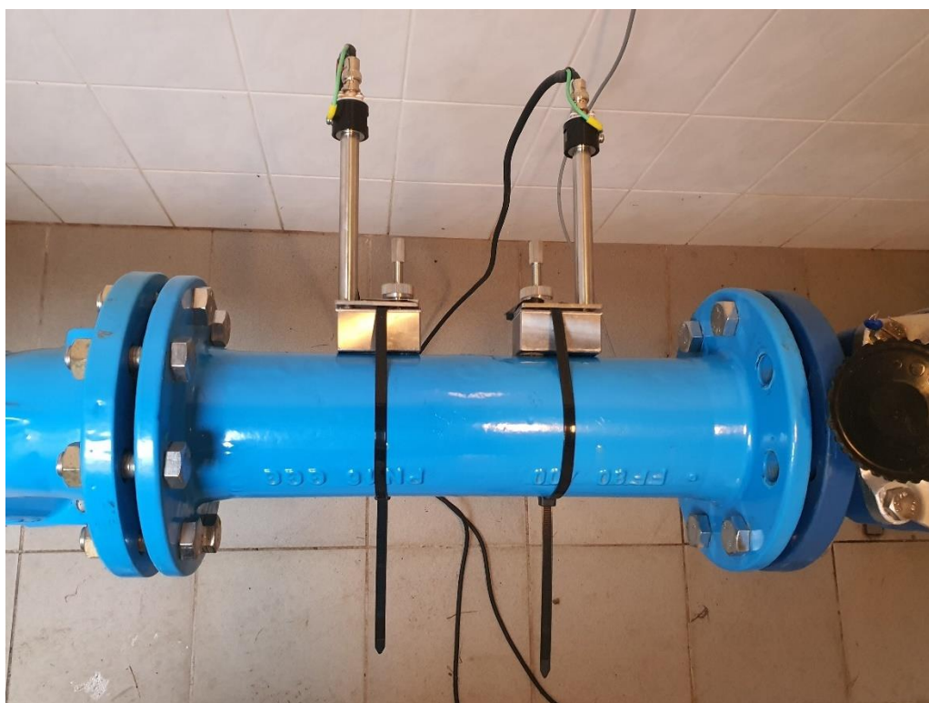
Obr. 0.2 Ultrazvukový prietokomer pri meraní experimentálnych dát univerzitou.
