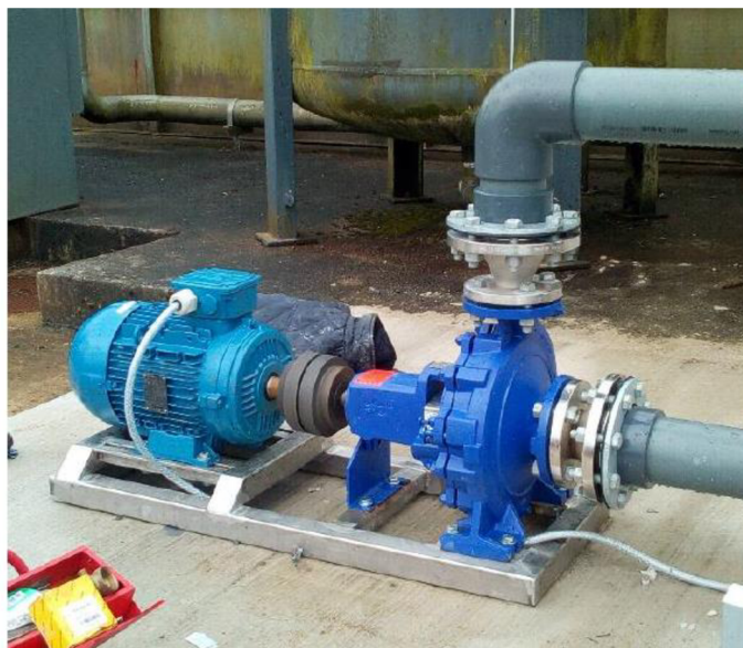
Obr. 1.1 Odstredivé čerpadlo rekuperačného systému Blackstairs GWS [3].
