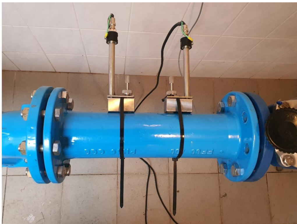
Obr. 0.2 Ultrazvukový prietokomer pri meraní experimentálnych dát univerzitou.
