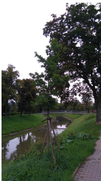
Obr. 42. Kotvení nekvalitní a nefunkční
