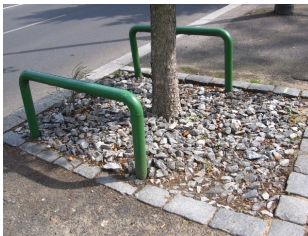
Obr. č. 29: Povrch výsadbové jámy je krytý kamennou drtí
