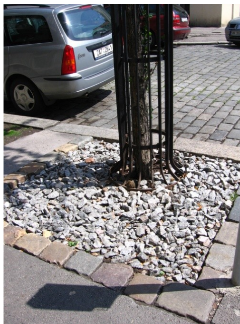
Obr. č. 15: Úprava povrchu výsadbové jámy
