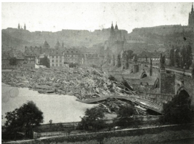
Obrázek 6: Karlův most ohrožován splaveným dřevem a předměty při povodni 1872. Foto F. Fridrich. (Státníková 2012)
