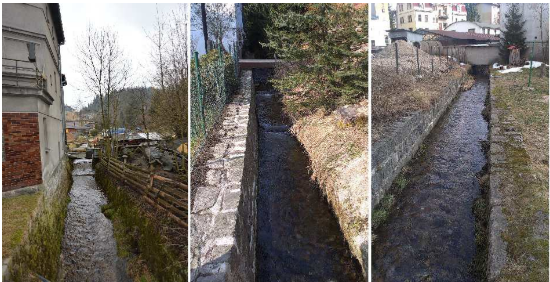
Obrázek 24: Ukázka souvislé úpravy koryta toku v intravilánu (autor, 2015).
