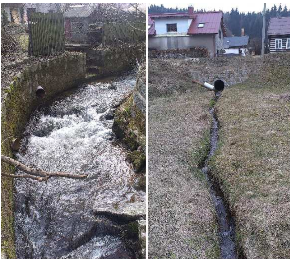
Obrázek 26: Obrázek vlevo ukazuje příklad zaústění svodů vody od přilehlých domů. Obrázek vpravo ukazuje jeden z mnoha pravostranných přítoků Smržovského potoka na úseku SP_6 (autor, 2016).
