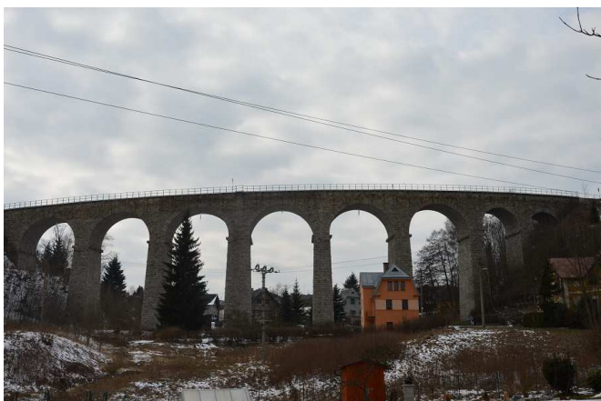
Obrázek 14: Železniční viadukt na Smržovce postavený z liberecké žuly (autor, 2016).
