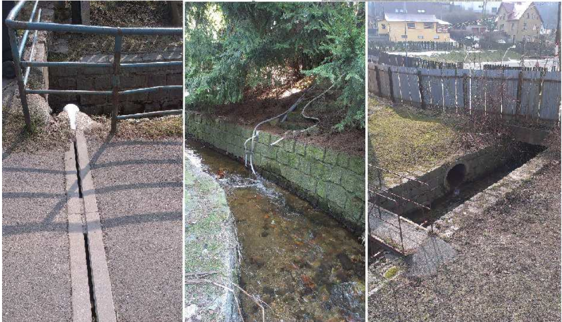
Obrázek 23: Obrázek nalevo ukazuje svod pro srážkovou vodu ze silnice. Obrázek uprostřed zobrazuje vývod vody (převážně vedené z okapů) do potoka. Obrázek napravo zobrazuje zaústění drobného zatrubněného přítoku.
