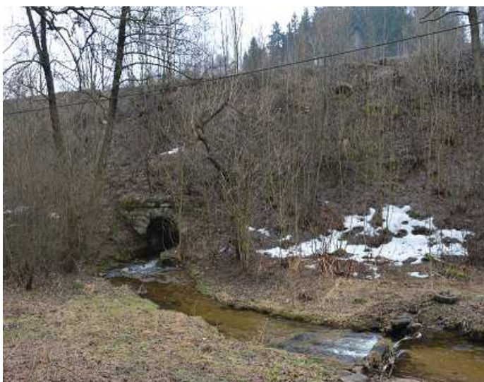
Obrázek 22: Začátek čtvrtého úseku začíná vtokem do tunelu pod železniční tratí (autor, 2015).
