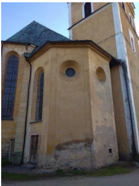
Obr. 11: Frýdlant, kostel Nalezení sv. Kříže, pohřební kaple Redernů, exteriér
