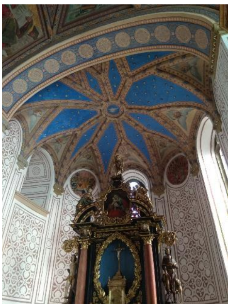
Obr. 6: Frýdlant, zámek, kaple sv. Any, klenba
