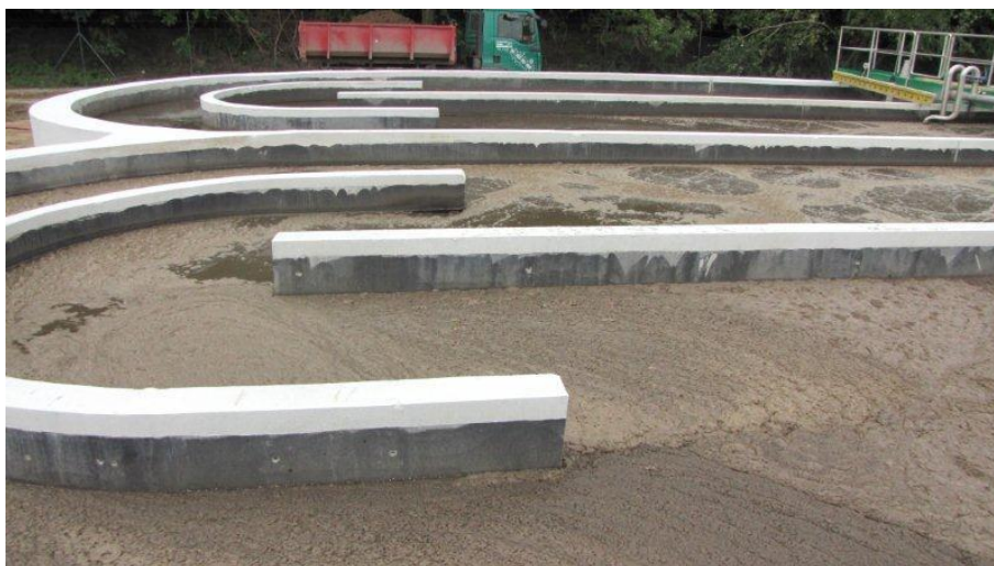
Obr. 13 Biologický stupeň čištění odpadních vod – aktivovaný kal [24].
