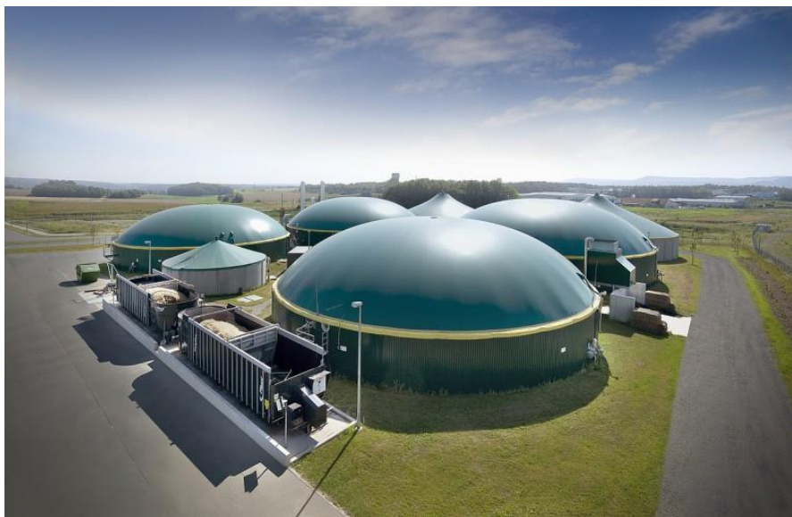
Obr. 1 BPS Hodkovice s charakteristickými fermentačními nádržemi [8].
