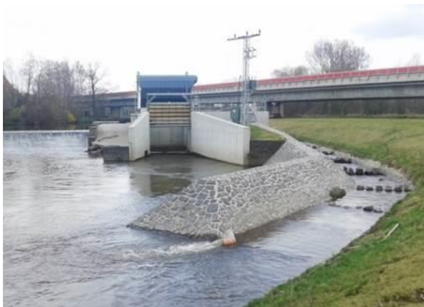
Obr. č. 6 Malá vodní elektrárna ve Svijanech
