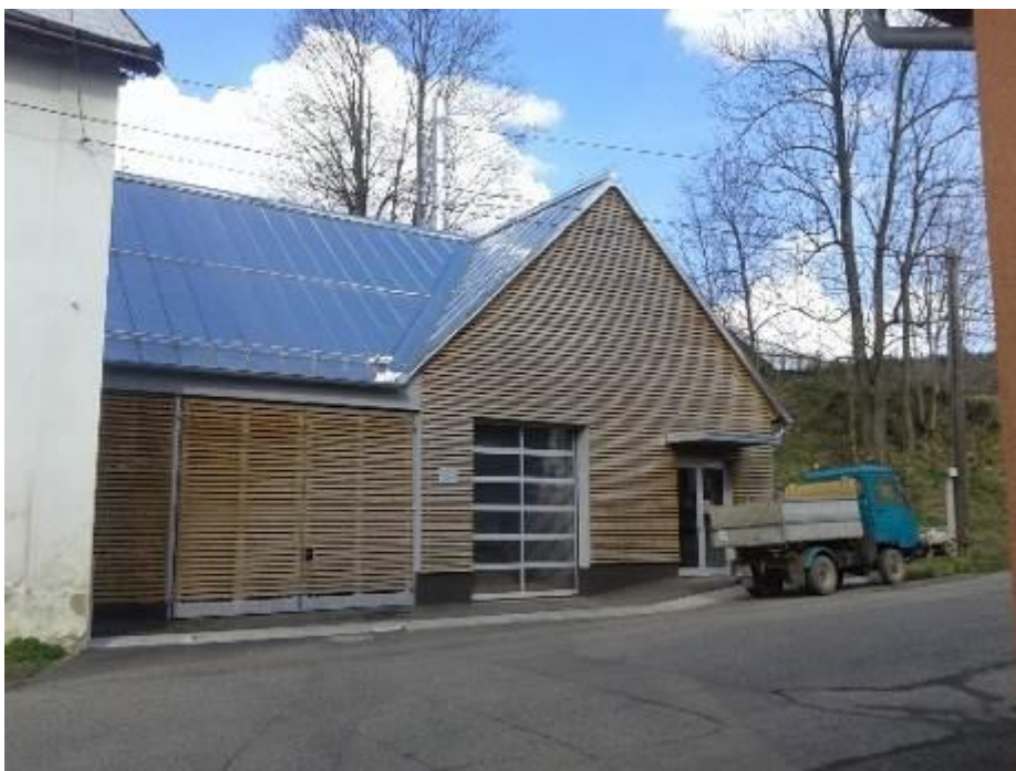
Jižní pohled na budovu obecní výtopny v Oldřichově v Hájích
