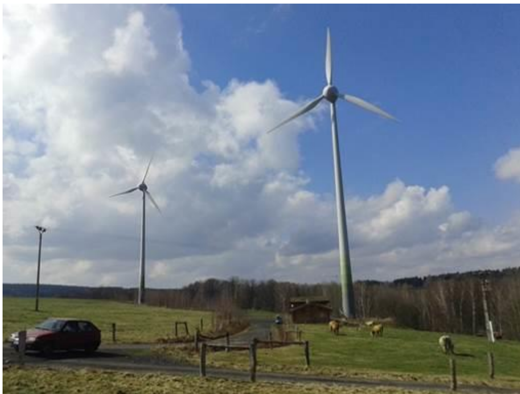
Obr. č. 10 Větrná elektrárna v Jindřichovicích pod Smrkem
