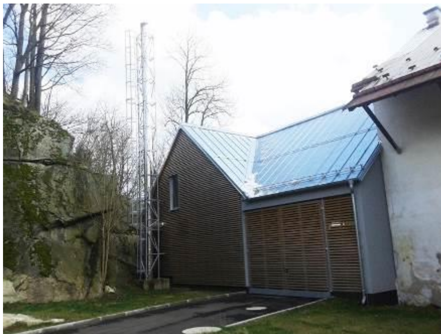
Obr. č. 17 Výtopna na biomasu v obci Oldřichov v Hájích
