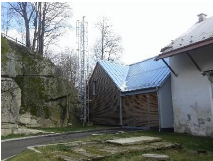
Severní pohled na budovu obecní výtopny v Oldřichově v Hájích
