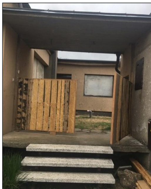
Obr. č. 28 - Zabezpečené výplně otvorů [vlastní]
