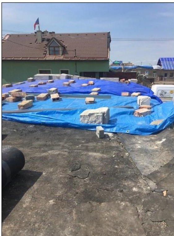
Obr. č. 19 - Zabezpečení střešního pláště garáže [vlastní]
