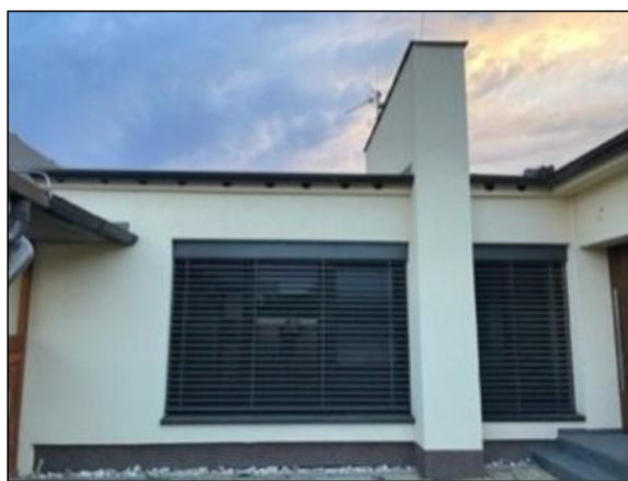
Obr. č. 31 - Rodinný dům po opravách [vlastní]
