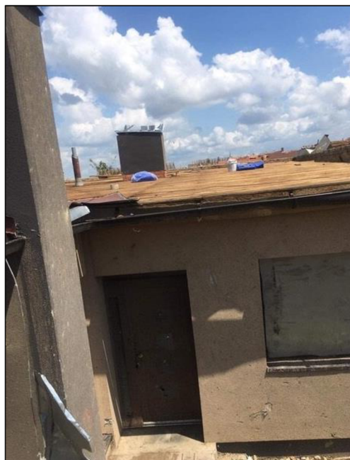
Obr. č. 16 - Střecha rodinného domu v průběhu oprav [vlastní]
