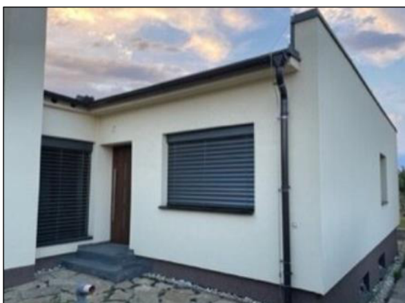
Obr. č. 30 - Rodinný dům po opravách [vlastní]
