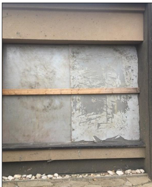
Obr. č. 27 - Zabezpečení výplně otvoru [vlastní]
