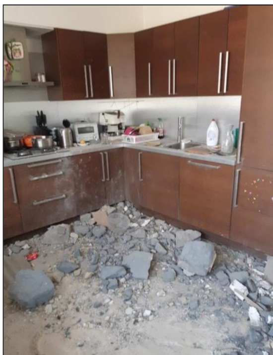
Obr. č. 29 - Suť z otvoru v obvodové zdi v kuchyni [vlastní]
