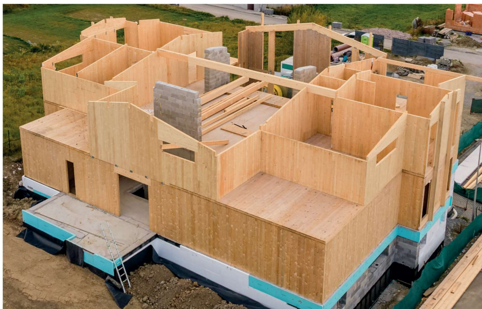
Obrázek 5 dřevostavba z CLT panelů
