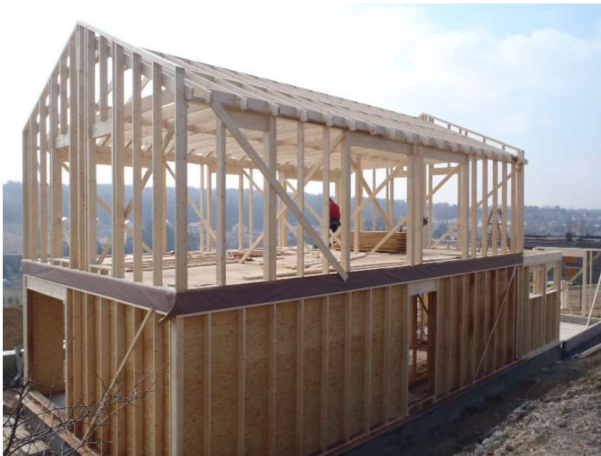
Obrázek 8 Dřevostavba platform frame
