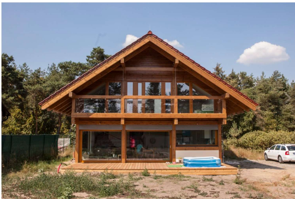
Obrázek 4 Dřevostavba z těžkého skeletu
