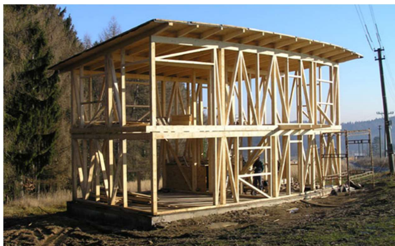
Obrázek 6 Konstrukce sloupkové dřevostavby
