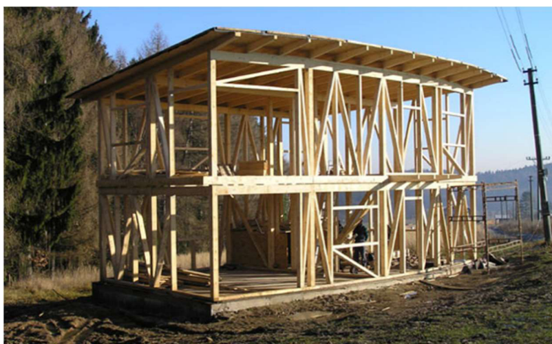
Obrázek 6 Konstrukce sloupkové dřevostavby
