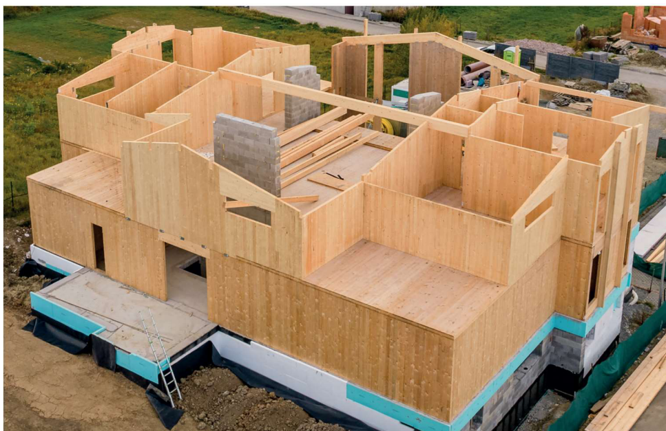
Obrázek 5 dřevostavba z CLT panelů
