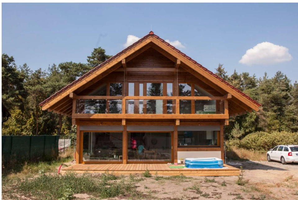
Obrázek 4 Dřevostavba z těžkého skeletu
