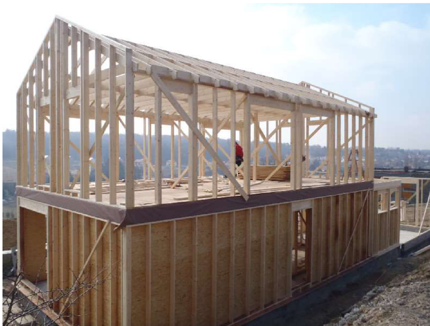
Obrázek 8 Dřevostavba platform frame
