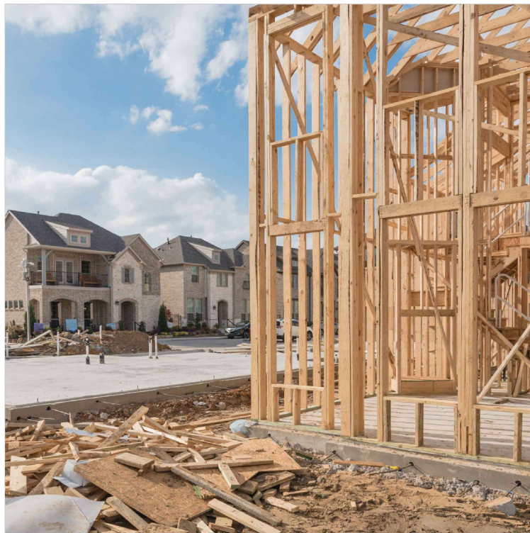
Obrázek 7 Balloon frame konstrukce
