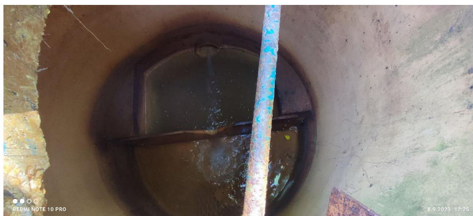
Obrázek 27: Odkalištní vody z dočišťovací nádrže (Kurtík, 2023).
