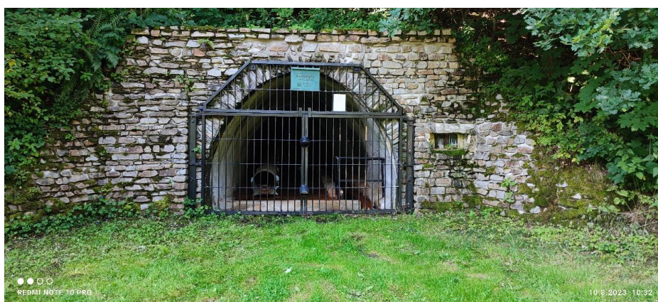
Obrázek 22: Odvodňovací štola Barbora (Kurtík, 2023).
