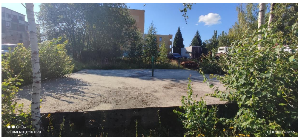
Obrázek 18: Jáma Huber, uzavřena železobetonovou deskou (Kurtík, 2023).
