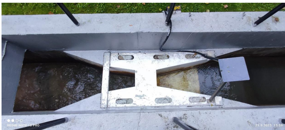
Obrázek 40: Výstup z ČDV, ID-017, Parshallův žlab (Kurtík, 2023).
