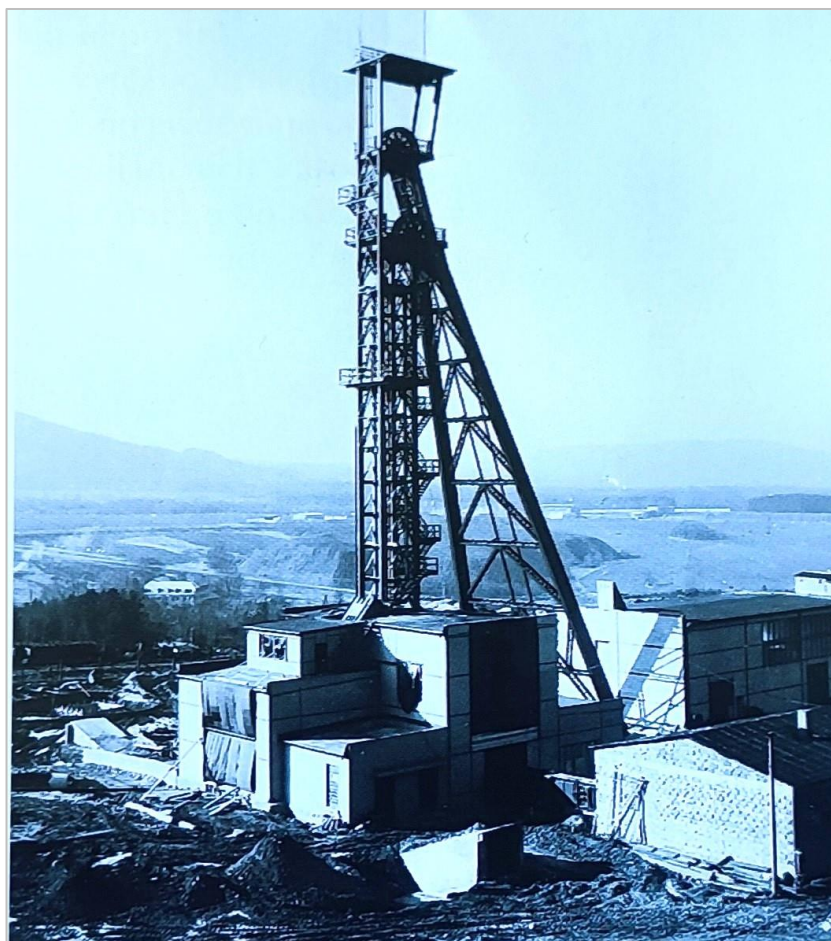
Obrázek 15: Výstavba nového závodu Stannum (Petřík, 1975).
