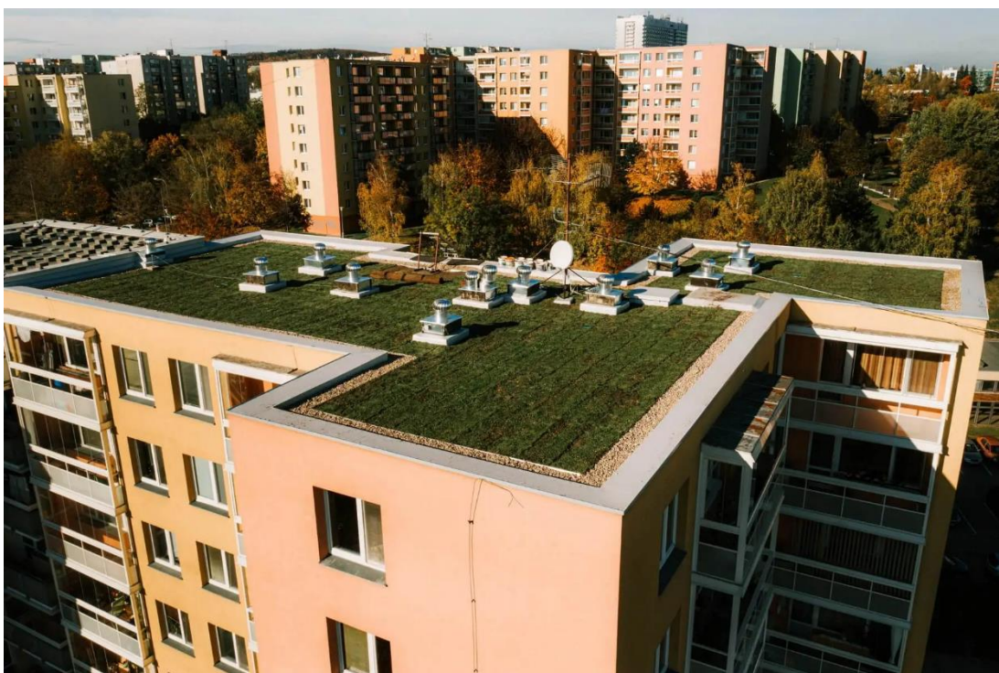
Obrázek 10: Realizace zelené střechy panelového domu na Brněnském sídlišti (greentop)
