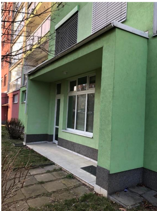
Obrázek 9: Stříšky sloužící ke sběru vody
