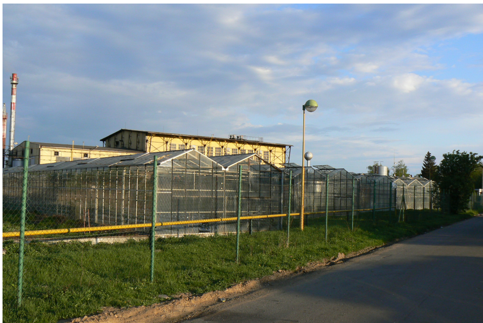
Obrázek 9: Pohled na skleníky u spalovny
