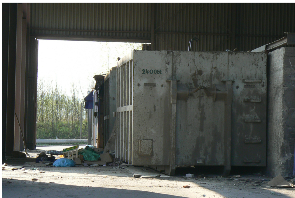
Obrázek 4: Pohled na vstup na překladiště v lokalitě skládky Určická
