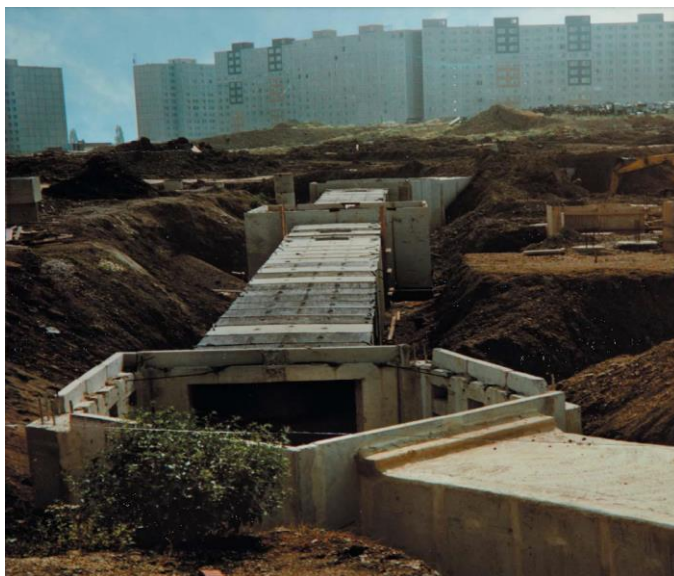
Obrázek 12 - Stavba kolektoru Lužiny
