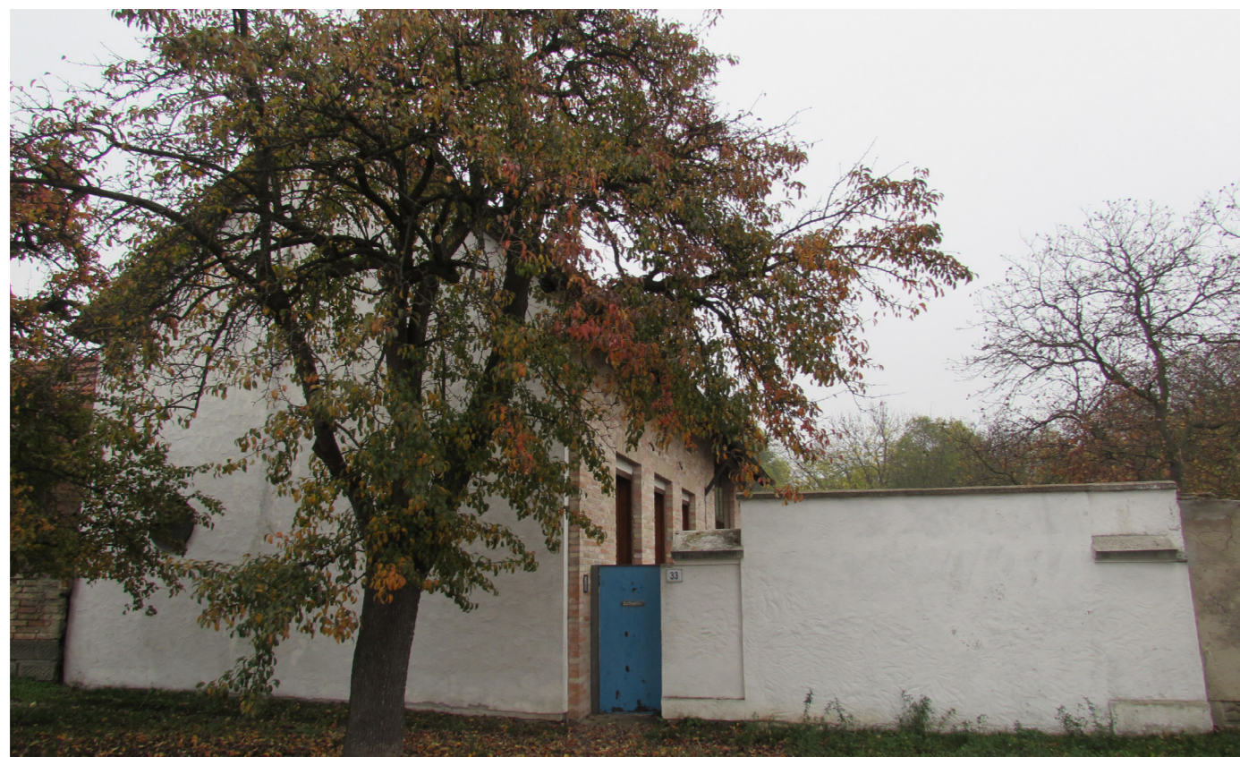
Obr. 18 Pohled na dům z ulice a vstup pro pěší.
