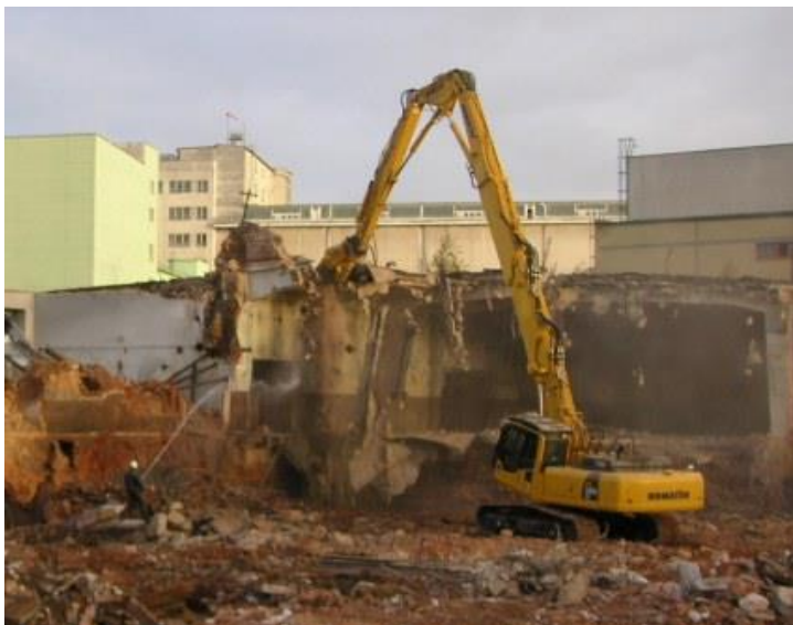
Demoliční bagr KOMATSU 350 - dlouhé rameno + nůžky
