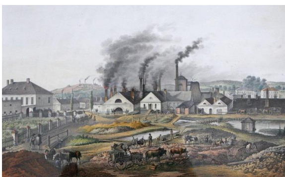
Obr. č. 8 Valdštejnská strojírna – Plzeň ( webový odkaz č. 5 )
