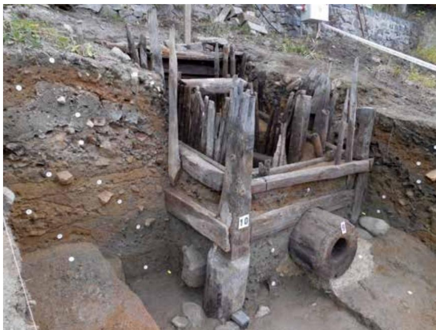
Obrázek 3.27: Horní výpust' (zdroj: Krajíc, 2019)
