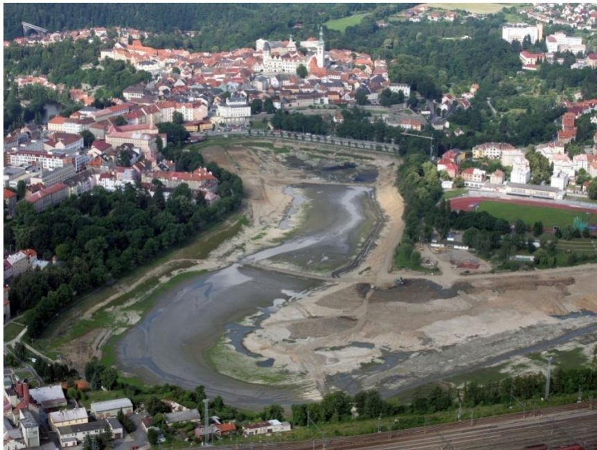
Obrázek 3.24: Vypuštěná vodní nádrž Jordán při akci „Obnova rybníka Jordán“ (zdroj: SG GEOTECHNIKA, 2022)
