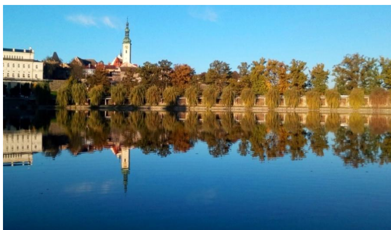
Obrázek 3.20: Pohled na vodní nádrž Jordán a jordánskou hráz (zdroj: vlastní)
