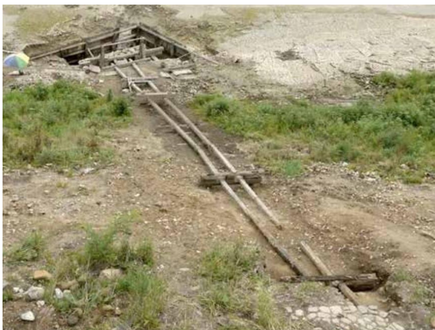
Obrázek 3.26: Severní spodní výpušť (zdroj: Krajíc, 2019)
