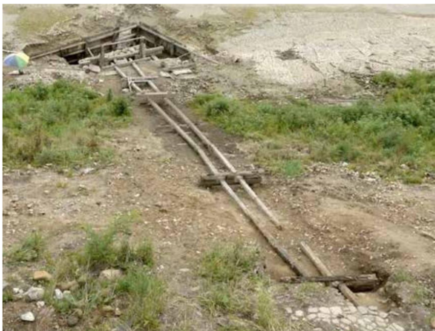
Obrázek 3.26: Severní spodní výpušť (zdroj: Krajíc, 2019)
