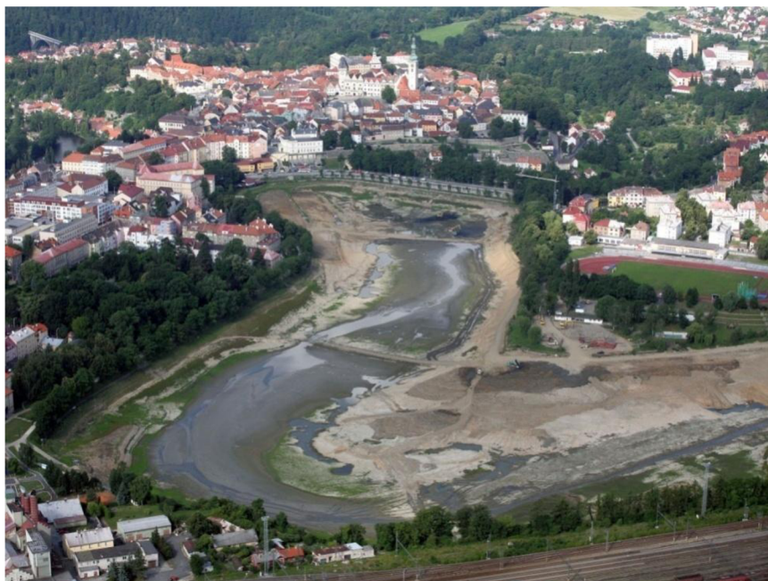
Obrázek 3.24: Vypuštěná vodní nádrž Jordán při akci „Obnova rybníka Jordán“ (zdroj: SG GEOTECHNIKA, 2022)
