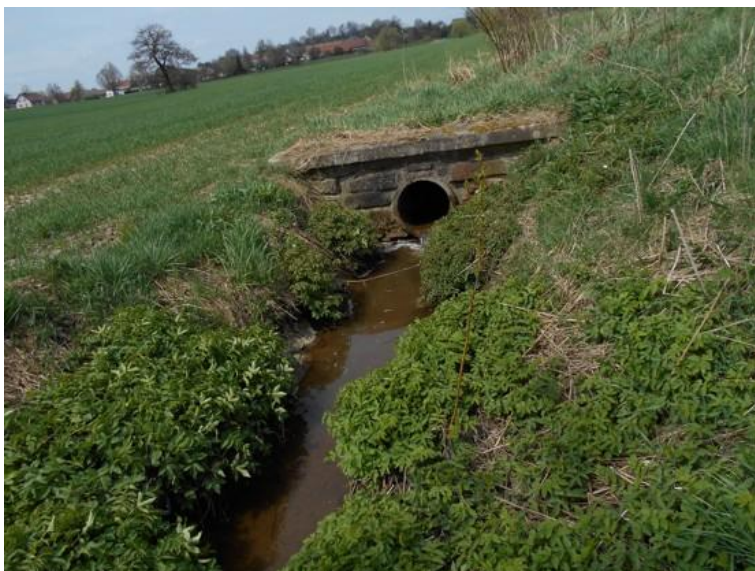
Foto 3.: vyústění zatrubněné části toku (A. Dvořáková, 27. 4. 2015, Nikon COOLPIX S2800)
