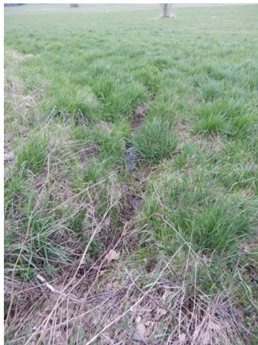
Foto 11.: samovolný vznik koryta v místě bývalého přítoku – km 12,10
