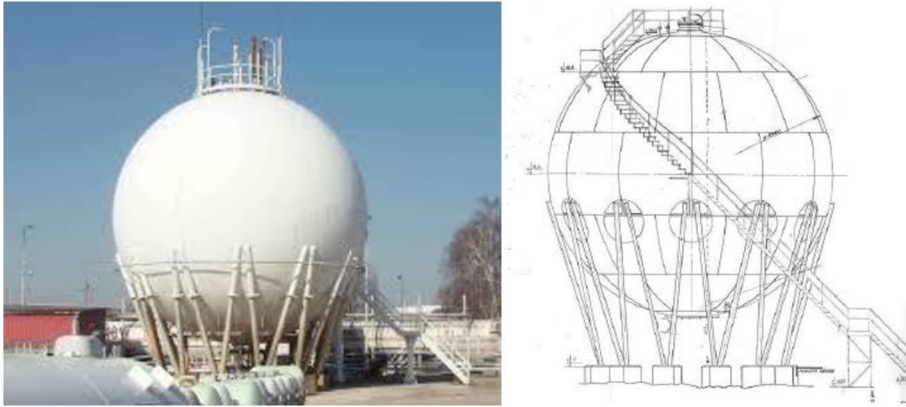
Obrázek 14 - Kulový zásobník na LPG Flaga s. r. o., zdroj: Systematická bezpečnostní studie kulových zásobníků na LPG metodou HAZOP, Flaga s. r. o.
