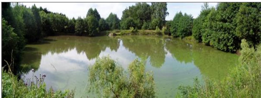
Obrázek 12: Biologická nádrž využívaná k čištění odpadních vod (Mlejnská 2015) (URL 6).
