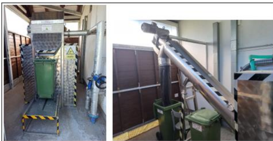
Obrázek 18: Válcové síto se separátorem písku.
