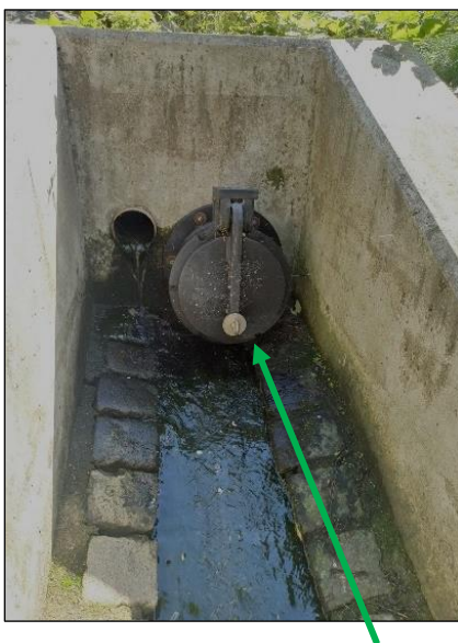
Obrázek 22: Žlab se zpětnou klapkou.
