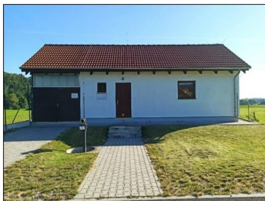
Obrázek 17: Budova ČOV Šabina.
