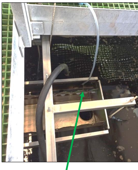
Obrázek 27: Ponořená odběrová sonda z výtoku odpadní vody z ČOV.
