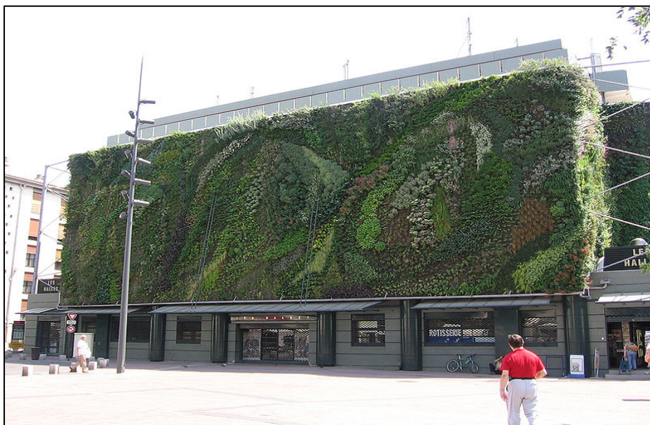
Obr. 9 Budova se zelenou stěnou, Avignon, Francie. ( http://commons.wikimedia.org/wiki/File:Mur_vegetal_avignon_jour1.jpg?uselang=cs )
