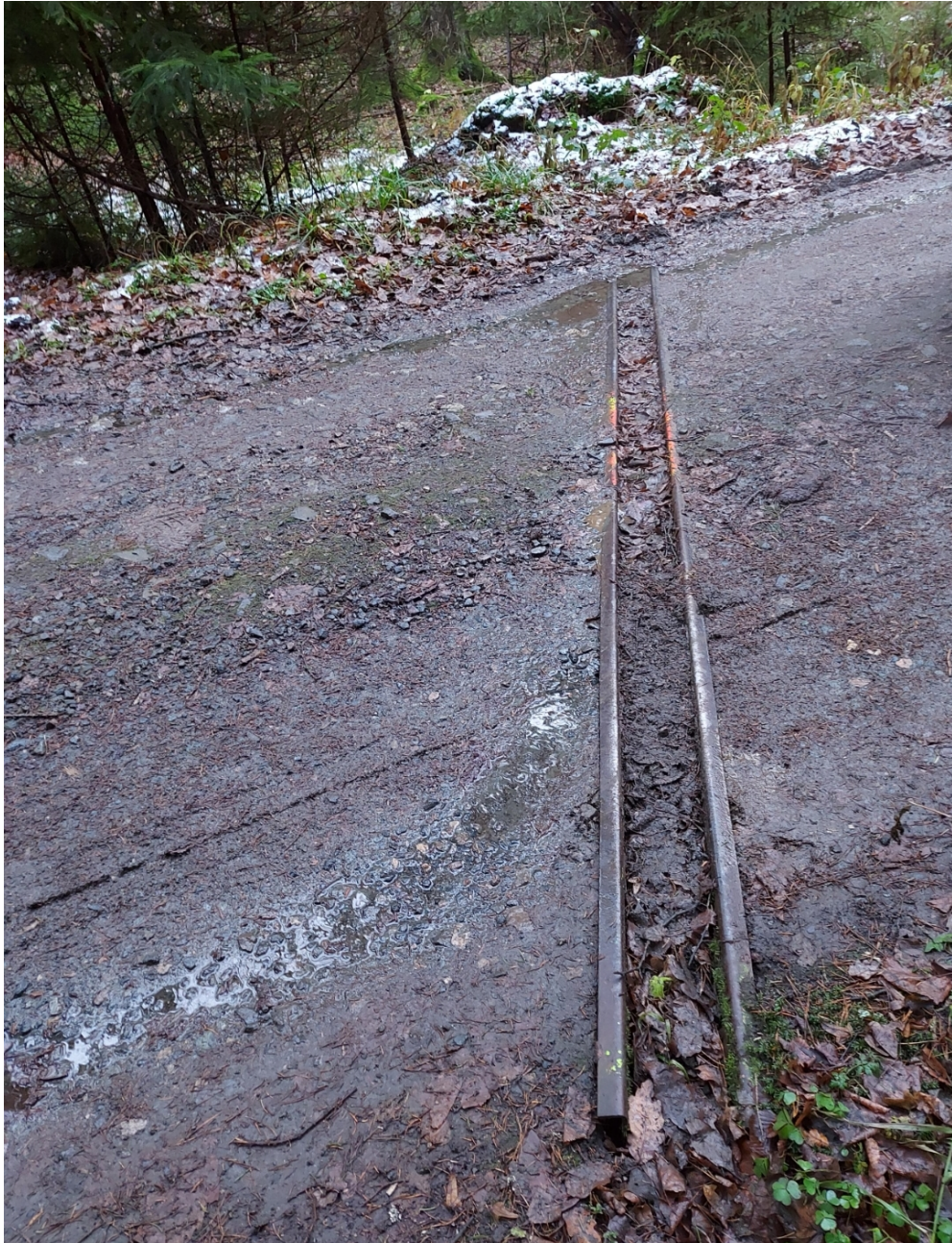
Obr. 19: Svodnice na lesní cestě 2L KO314/1
