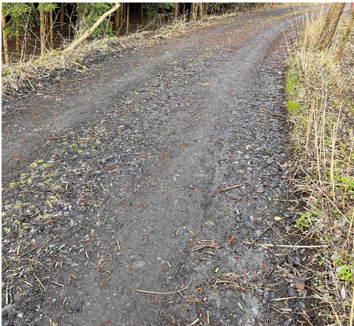
Obr. 48: První most přes Jevanský potok, pohled seshora
