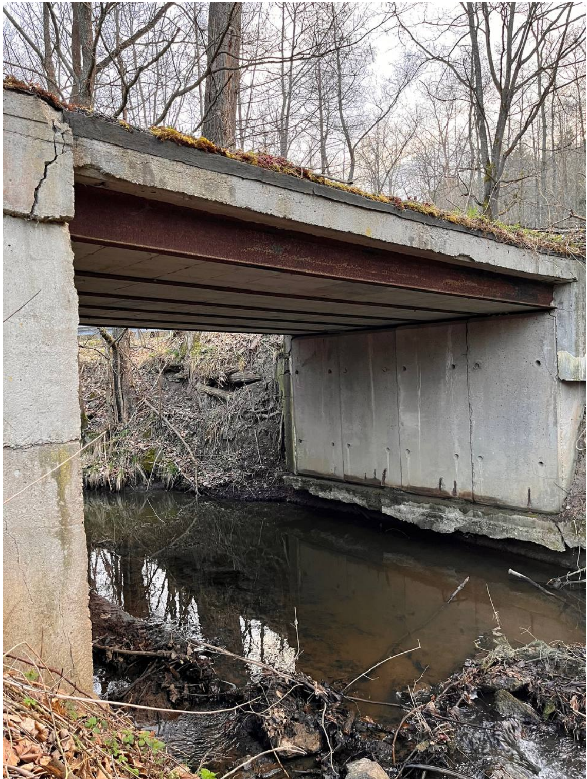
Obr. 50: Druhý most přes Jevanský potok, pohled zezdola
