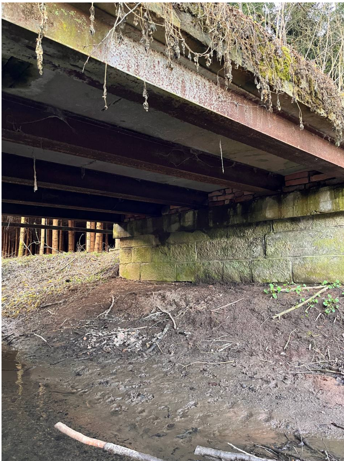
Obr. 49: První most přes Jevanský potok, pohled zezdola
