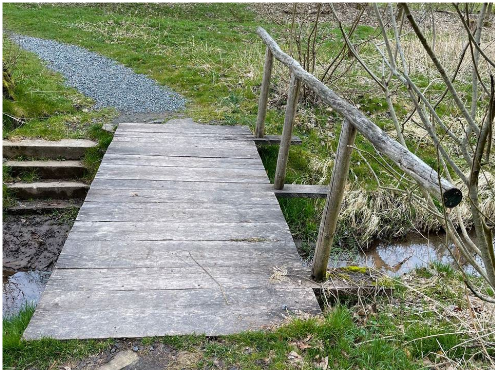
Obr. 21: Most přes Oplanský potok, pohled seshora
