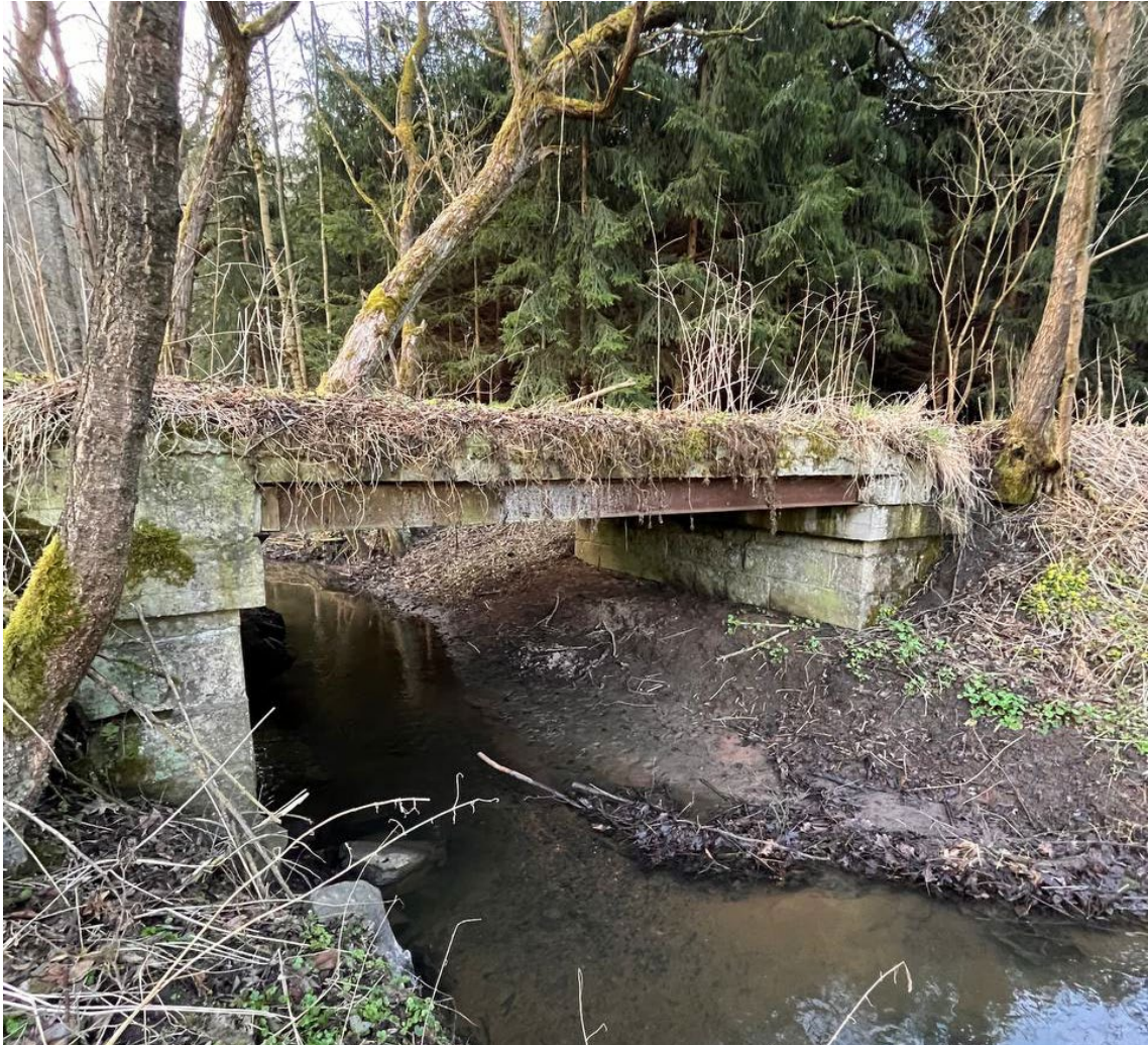
Obr. 22: První most přes Jevanský potok
