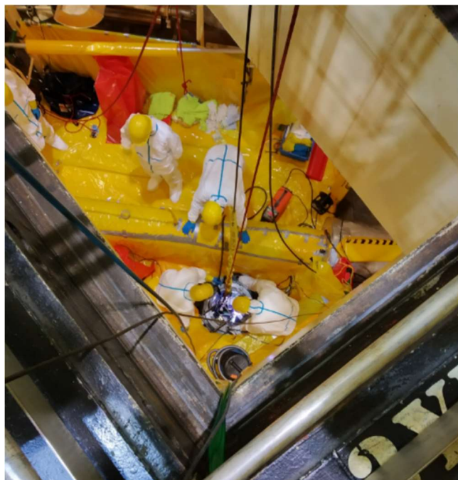
Obr. 57 Pracovní prostor opravy
