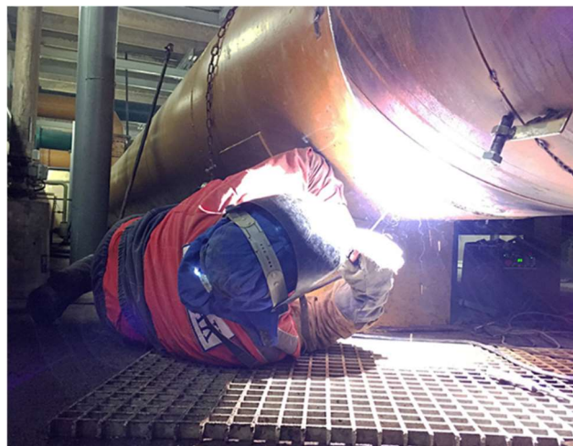
Obr. 18 Svařování potrubí metodou 111 [16]
