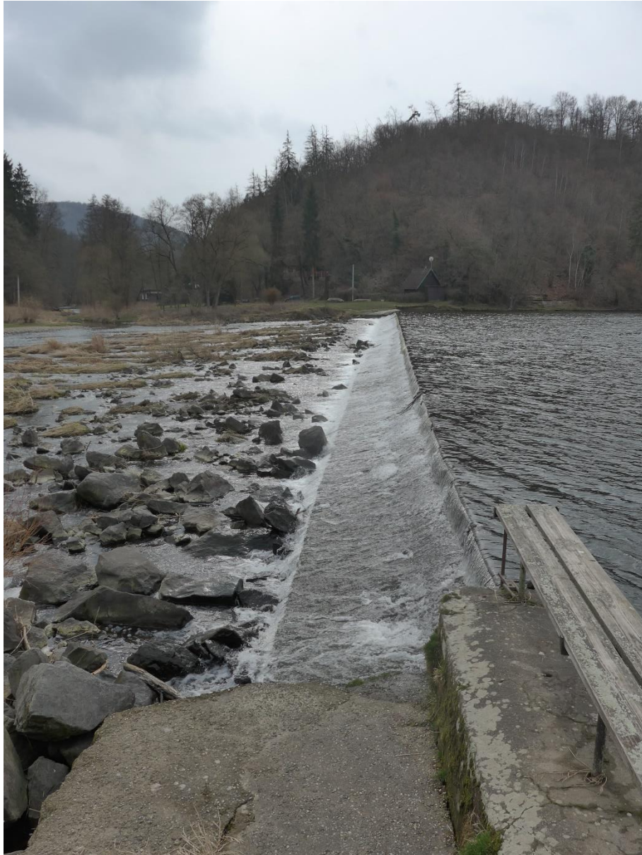
Obr.54: Pevný jez v Čilé opatřený dřevěnými náplátky (Novotný L., 2023).
