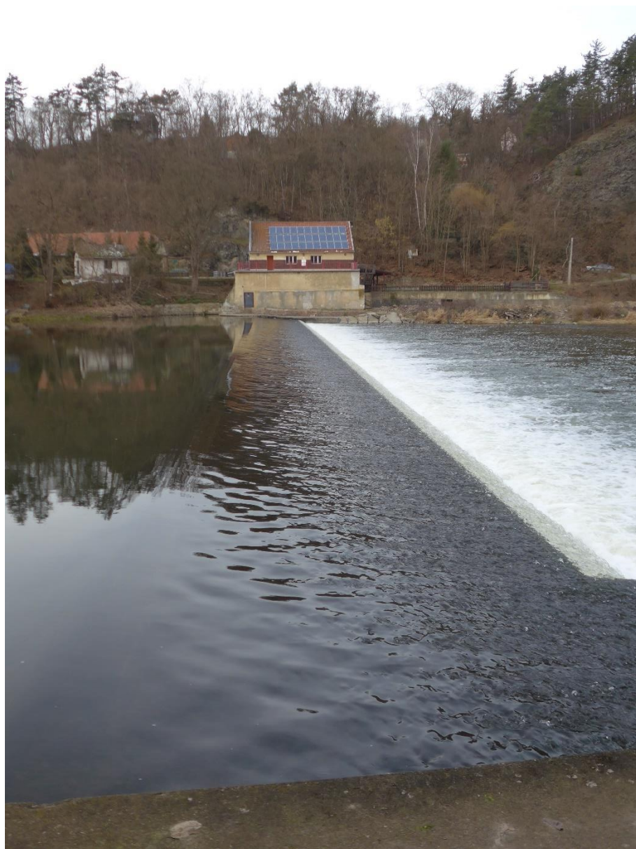
Obr.44: Pevný jez v Račicích s kamennou střechovitou přelivnou hranou (Novotný L., 2023).
