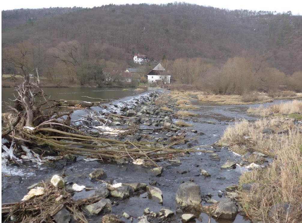
Obr.52: Pevný jez v Nezabudicích zanešený velkým množstvím splavenin (Novotný L., 2023).
