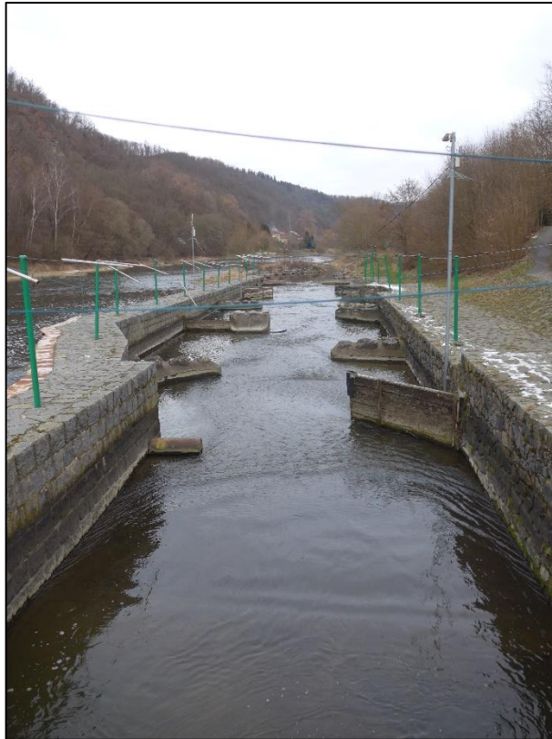
Obr.30: Sportovní propust na jezu v Roztokách (Novotný L., 2023).
