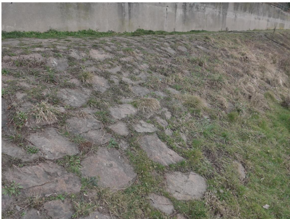
Obr.47: Detail břehového opevnění náplavky ve Zbečně provedeného jako kamenná rovnánina (Novotný L., 2023).
