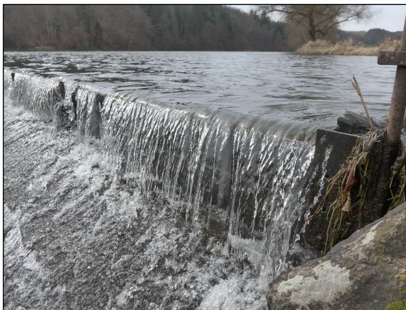
Obr.32: Náplatky na jezu Čilá (Novotný L., 2023).
