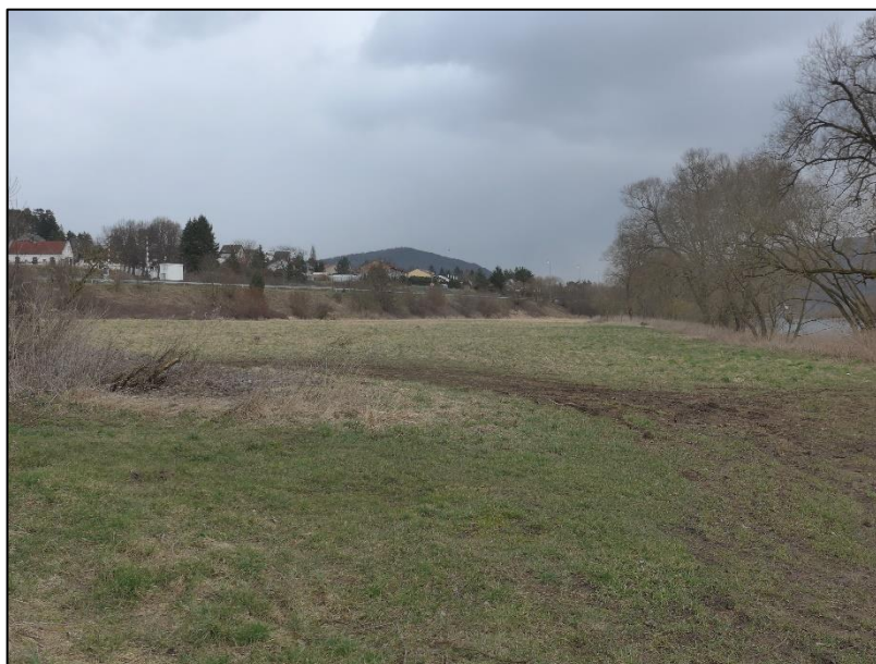
Obr.35: Luční berma chránící intravilán obce Hýskov (Novotný L., 2023).
