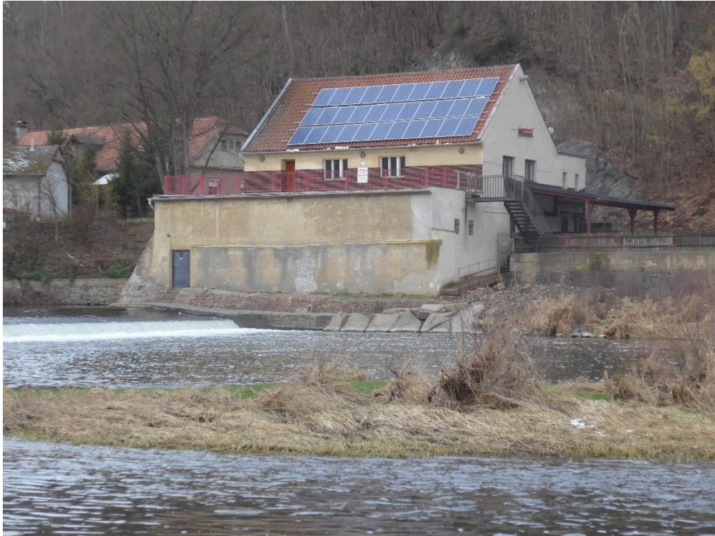
Obr.45: Bývalý mlýn „Valenták“ na jezu v Račicích, ve kterém je vybudována MVE (Novotný L., 2023).
