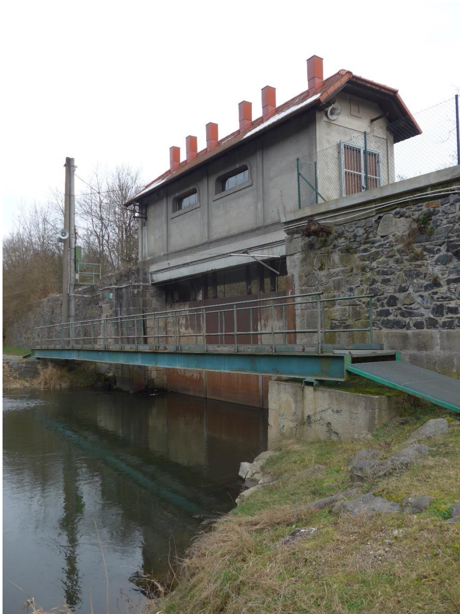
Obr.51: Vtok do náhonu k MVE Permon v Roztokách hrozený ocelovými stavidly (Novotný L., 2023).
