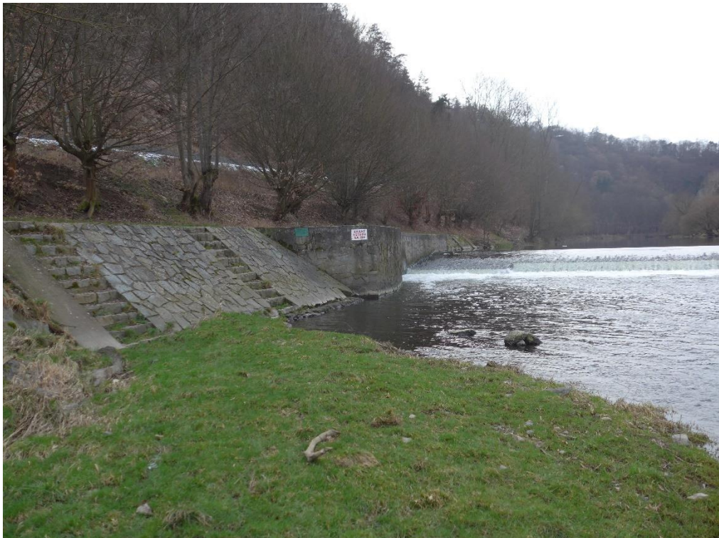
Obr.46: Břehové křídlo jezu provedené jako kamenná zeď a kamenná rovnanina zpevňující pravý břeh v podjezí (Novotný L., 2023).
