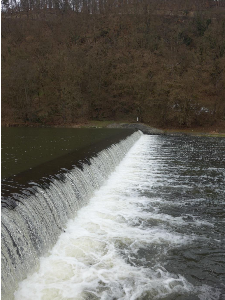
Obr.50: Pevný jez v Roztokách zakončený kamenným jezovým pilířem (Novotný L., 2023).
