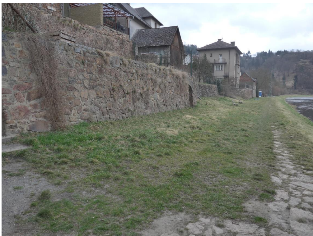
Obr.48: Kamenná zeď ukončující bermu náplavky ve Zbečně (Novotný L., 2023).
