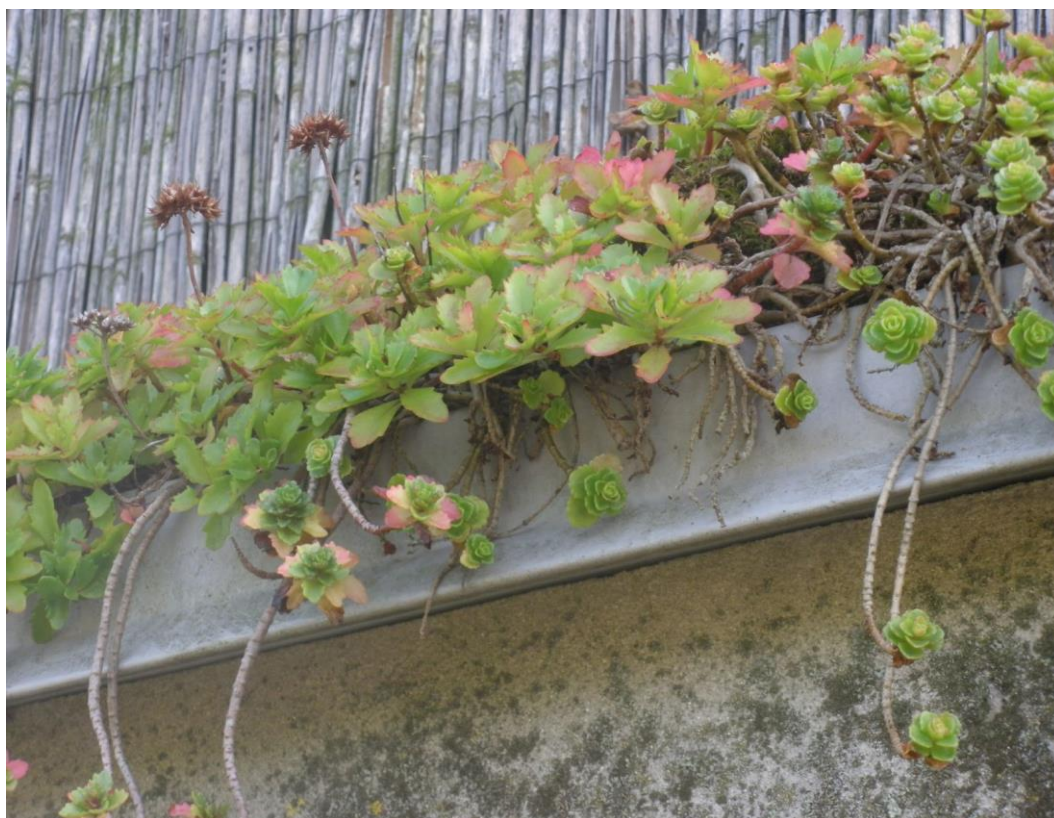
Obrázek 22: Římsa ozeleněná rozchodníky nad vstupem na zelenou střechu, Sedlice
