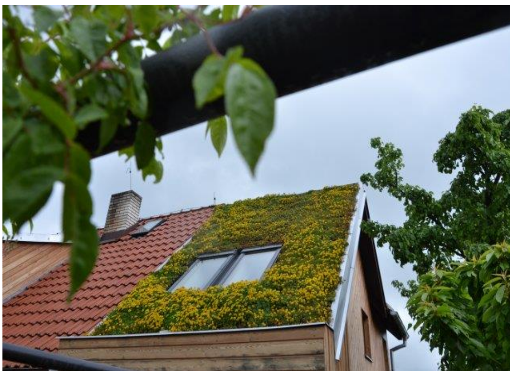
Obrázek 3: Extenzivní zelená střecha rodinného domu, Statenice (SZUZ ©2019)
