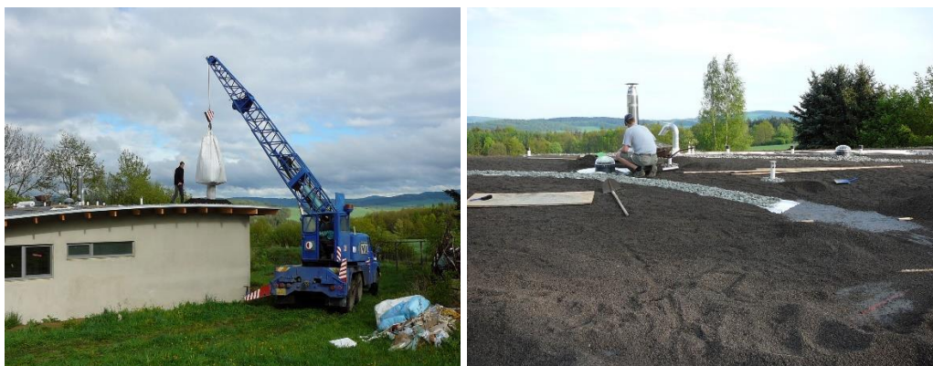
Obrázek 36 a, b: Přeprava a rozvrstvení substrátu na střechu, Únětice (Pavel Spodniak 2010)
