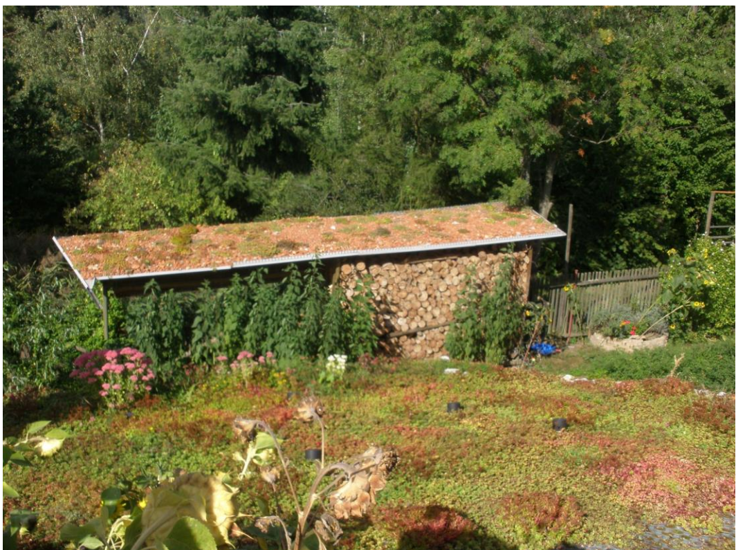
Obrázek 6: Přístřešek na dříví s extenzivní zelenou střechou, v popředí zelená pobytová střecha, Sedlice
