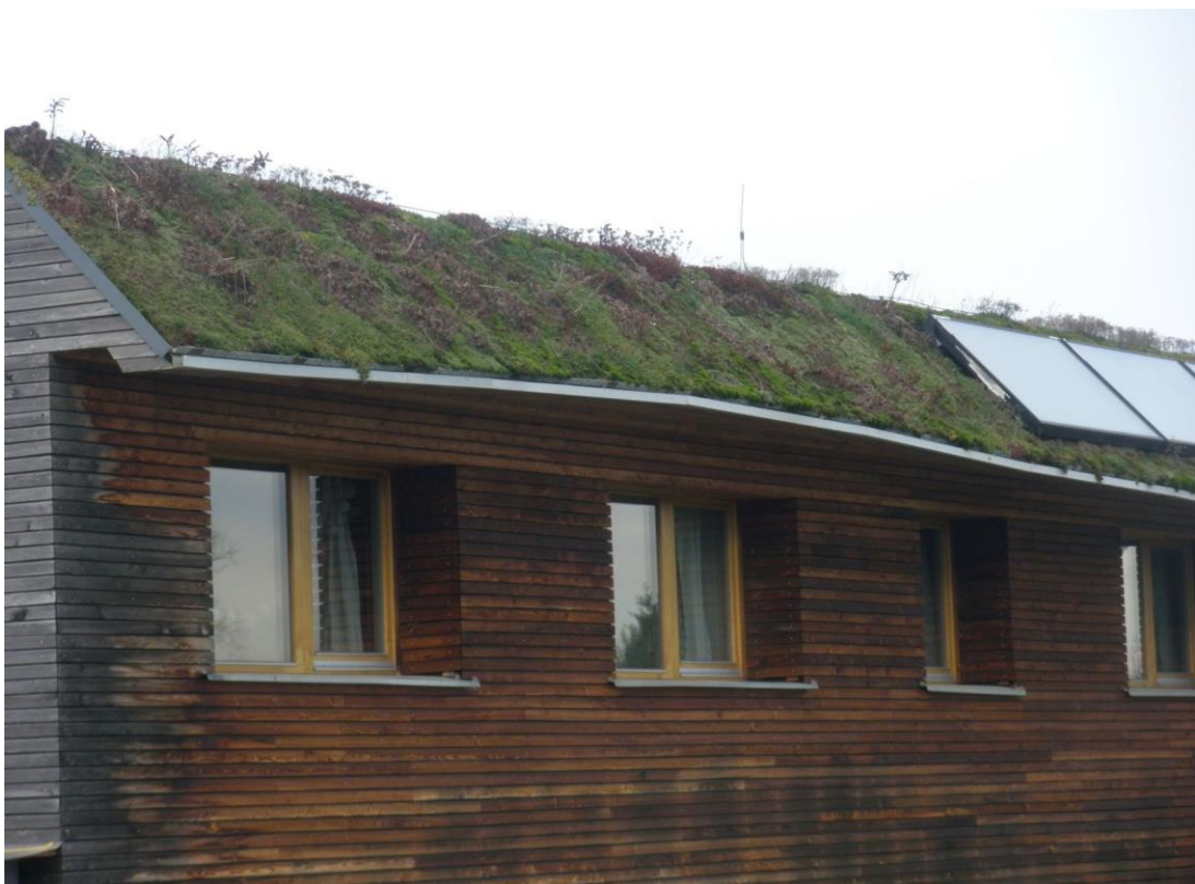
Obrázek 43 a, b, c: Čelní a boční pohledy na zelenou střechu, Rožmitál pod Třemšínem
