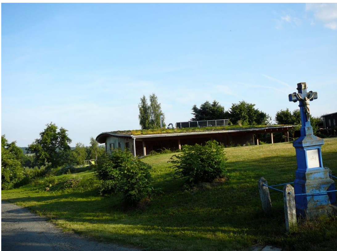
Obrázek 34: Rodinný pasivní přízemní dům/dřevostavba se zelenou extenzivní střechou ve tvaru vlny, Únětice (Pavel Spodniak 2018)
