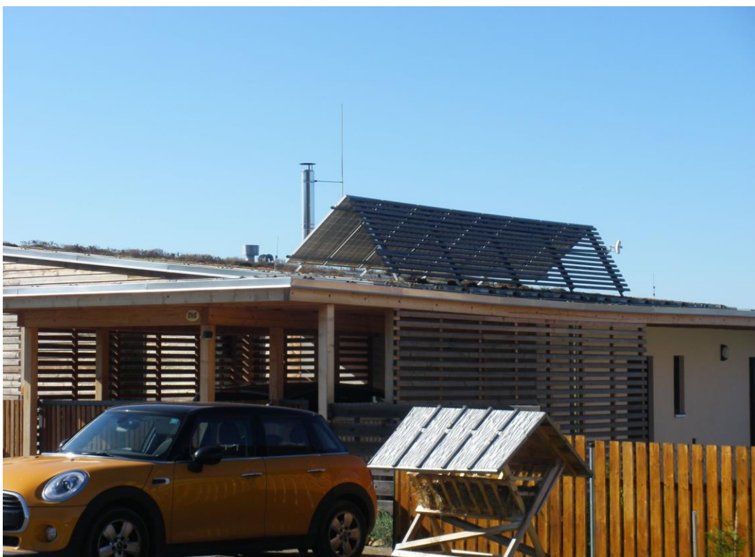
Obrázek 27: Rodinný téměř pasivní dům/dřevostavba se zelenou extenzivní a štěrkovou střechou, Chodouň
