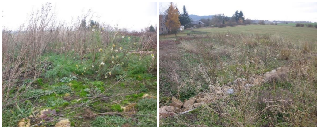
Obrázek 45 a, b: Nepokosená vegetace zelené střechy, Rožmitál pod Třemšínem
