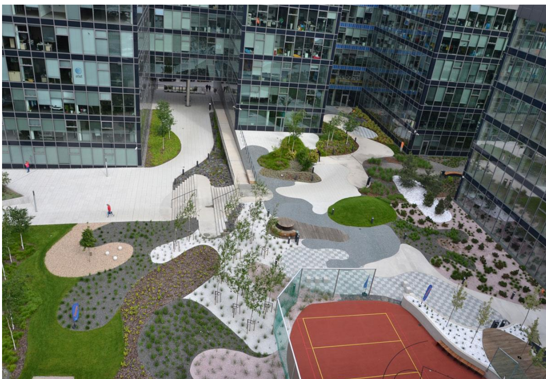
Obrázek 9: Intenzivní zelená střecha Campus park, Brno (SZUZ ©2019)
