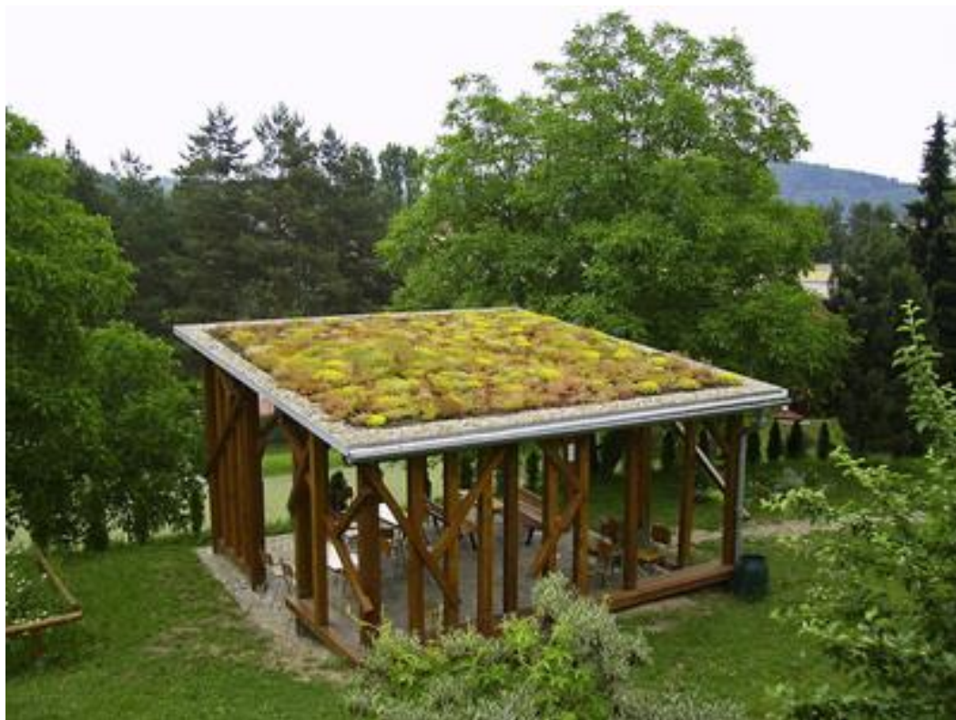
Obrázek 4: Lehká extenzivní zelená střecha na zahradním altánu ZŠ Heyrovského, Brno (GreenVille ©2013)
