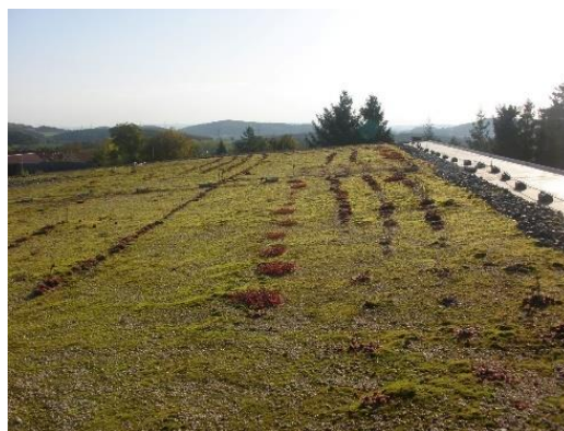
Obrázek 25: Řady netřesků na zelené střeše, Jablonná
