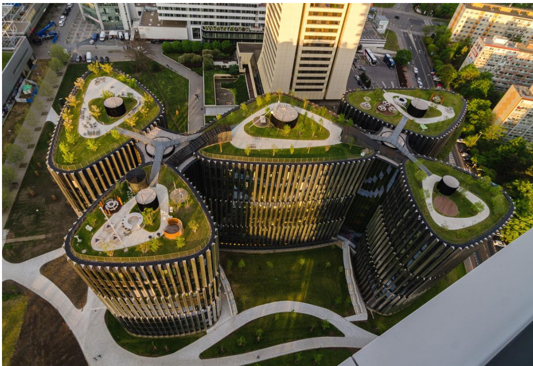
Obrázek 8: Intenzivní zelená střecha budovy Main Point Pankrác, Praha (SZUZ ©2019)
