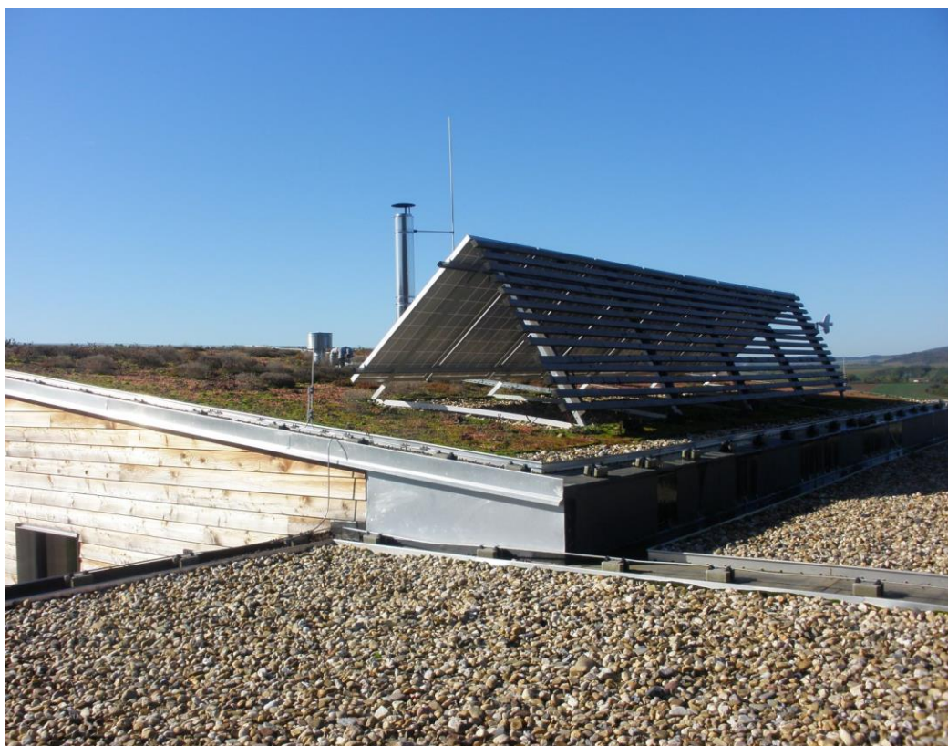
Obrázek 30: Pohled na dokončenou zelenou a šěrkovou střechu, Chodouň
