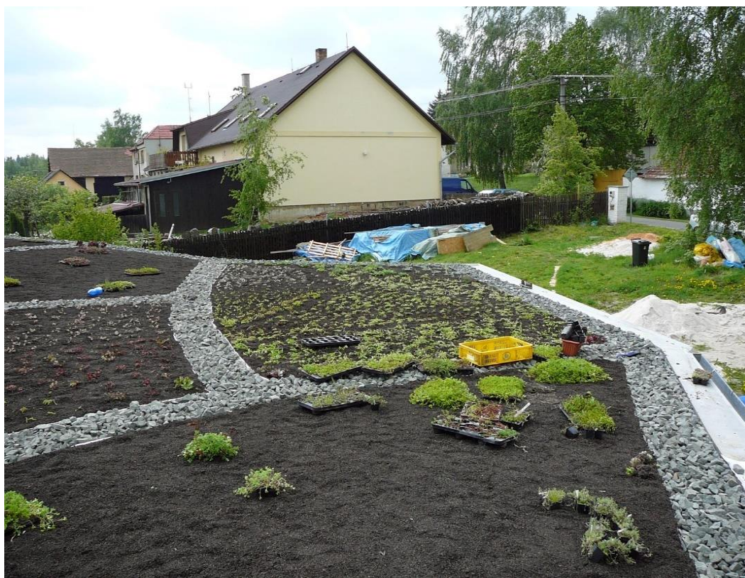
Obrázek 37: Výsadba 6 500 ks různorodých rostlin-rozchodníků na ozelenění střechy, Únětice (Pavel Spodniak 2010)
