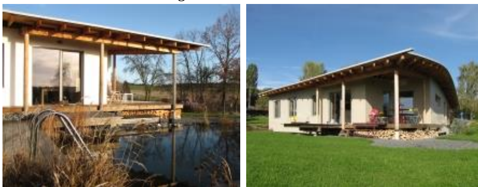
Obrázek 35 a, b: Realizace přízemní dřevostavby s vlastnostmi stavby zděné, založené nad terénem na vrtkavých pilotkách (ABATELIÉR)
