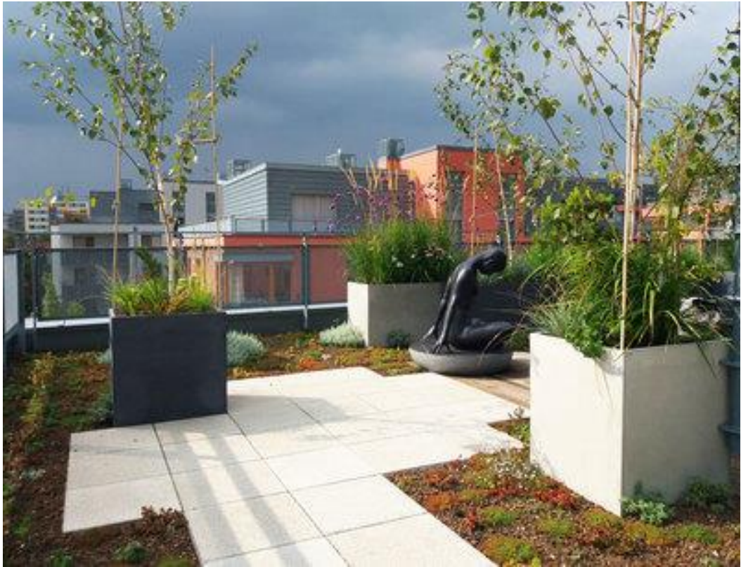
Obrázek 10: Polo-intenzivní zelená střecha na terase bytového domu, Praha (SZUZ ©2019)
