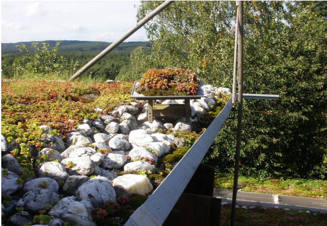
Obrázek 17: Detaily zakončení zelené střechy ateliéru, Sedlice
