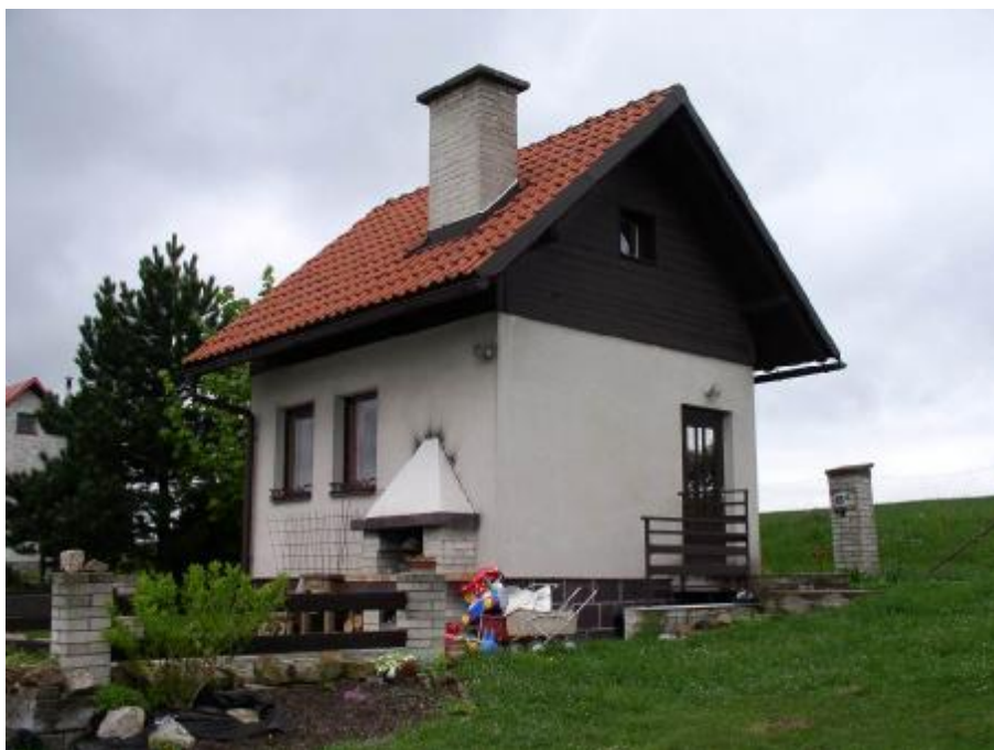
Obrázek č. 18 - Celkový pohled na objekt
