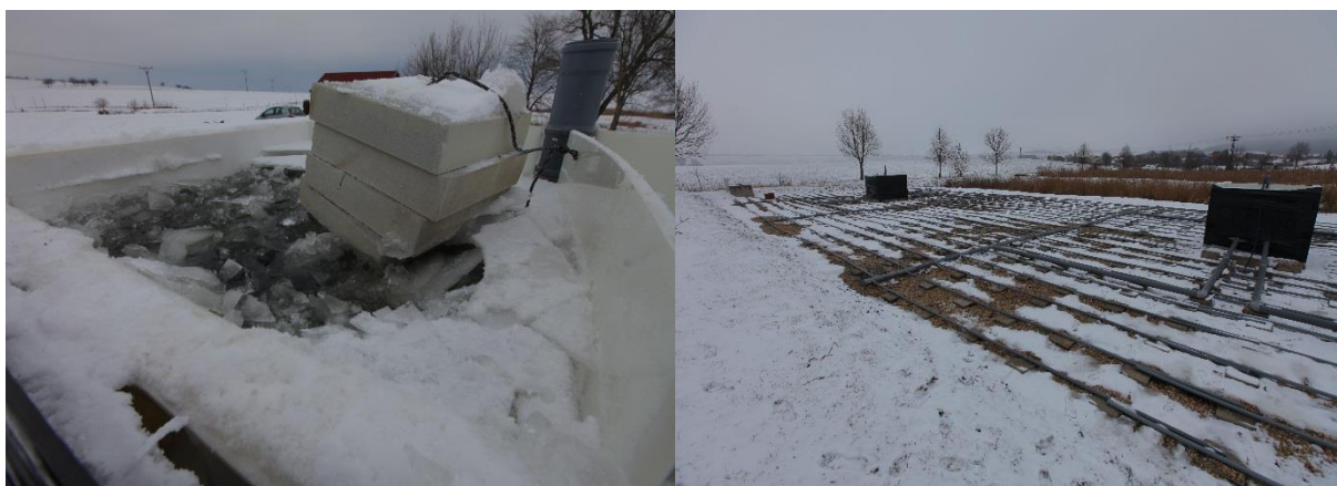
Obr. 35. Zamrznutí šachtové komory (vlevo), pohled na VF v zimním období (vpravo), (archiv ÚVHK)
