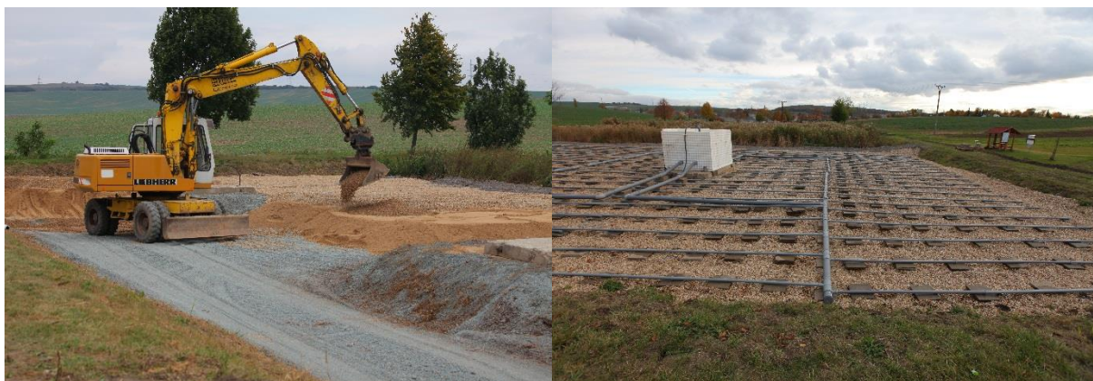
Obr. 22. Průběh výstavby zpevněných ploch pro rozdělovací šachty (vlevo), pohled na rozdělovací šachtu na vertikálním filtru (vlevo), (archív ÚVHK)
