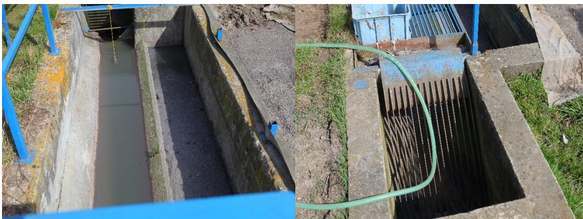
Obr. 14. Štěrbinový lapák písku (vlevo), ručně stírané česle (vpravo)
