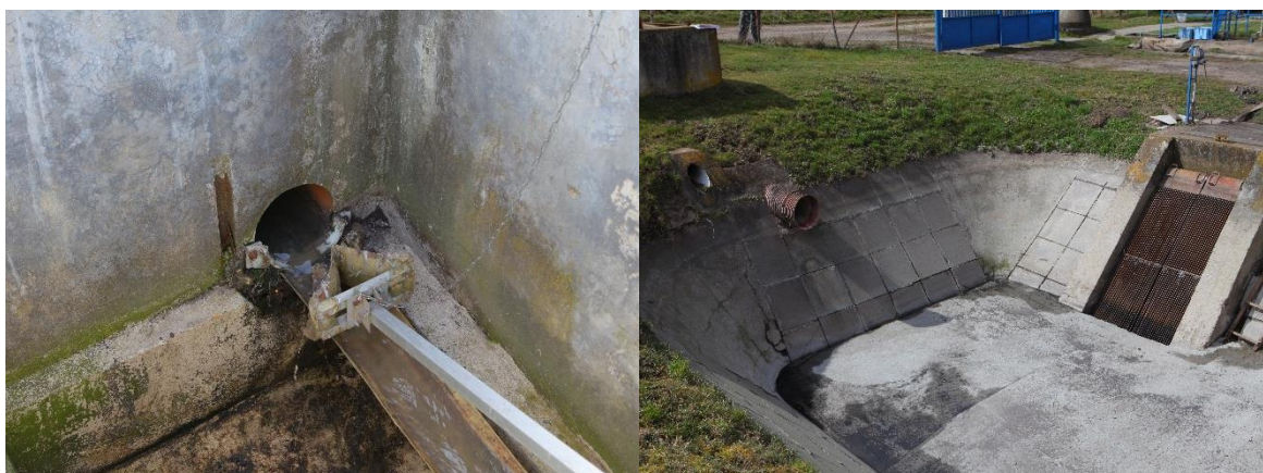
Obr. 13. Odlehčovací komora (vlevo), dešťová zdrž (vpravo)
