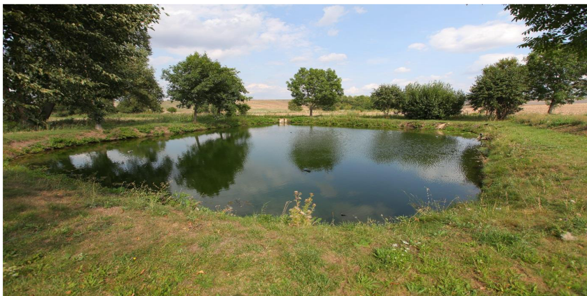
Obr. 16. Stabilizační biologická nádrž (archív ÚVHK)
