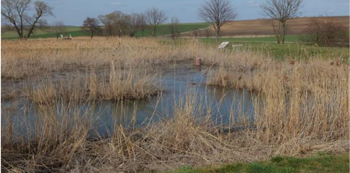
Obr. 10. Ukázka kolmatace na horizontálním poli ( archiv ÚVHK )
