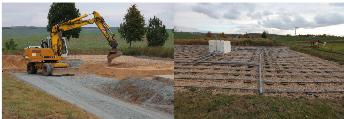
Obr. 22. Průběh výstavby zpevněných ploch pro rozdělovací šachty (vlevo), pohled na rozdělovací šachtu na vertikálním filtru (vlevo), (archiv ÚVHK)
