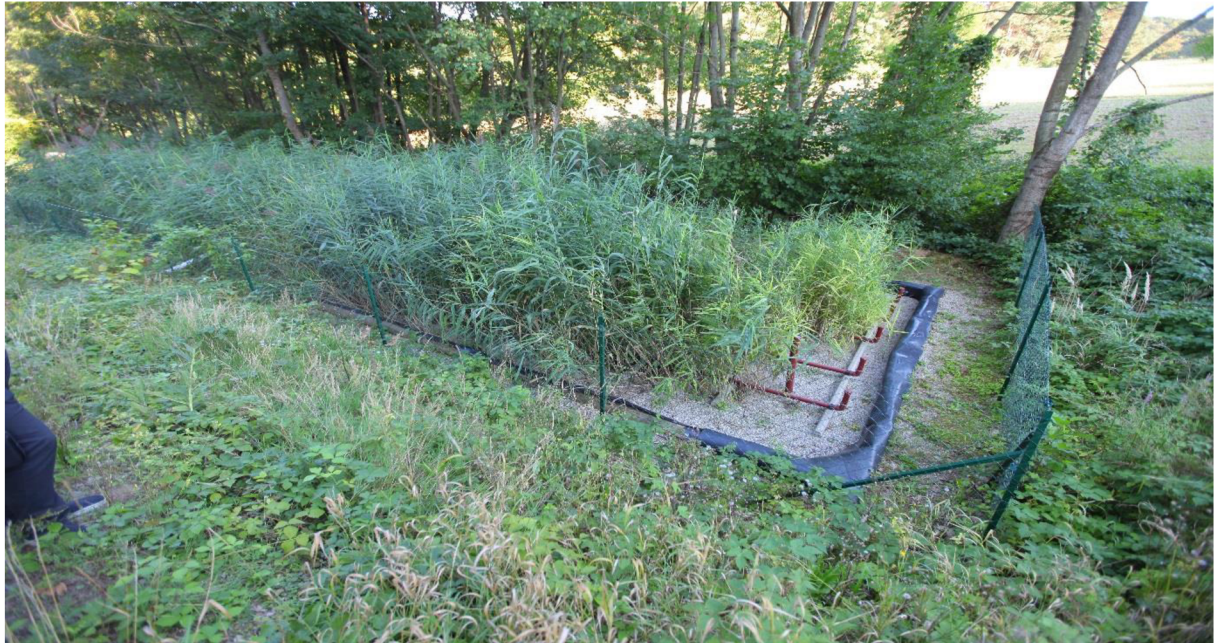
Obr. 8. Ukázka vertikálního filtru na kořenové čistírně ( Archiv ÚVHK)
