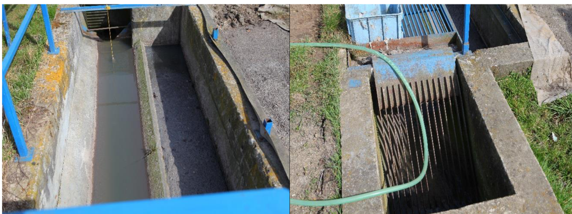
Obr. 14. Štěrbínový lapák písku (vlevo), ručně stírané česle (vpravo)
