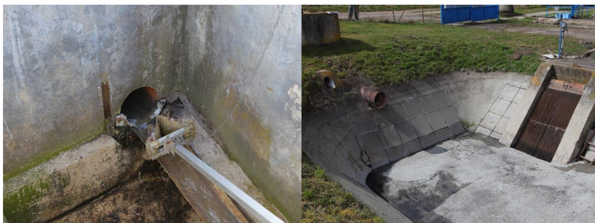
Obr. 13. Odlehčovací komora (vlevo), dešťová zdrž (vpravo)
