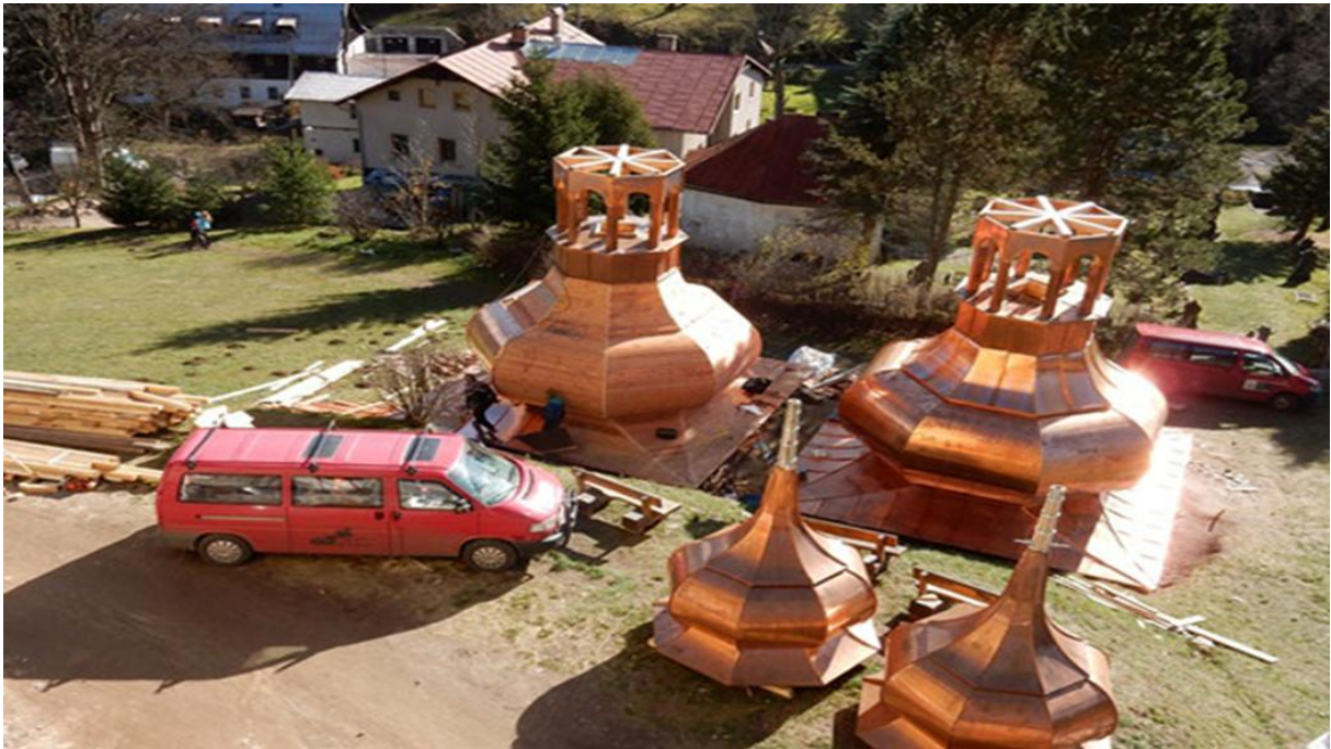
Obr. 36: Příprava opláštění barokních bání
