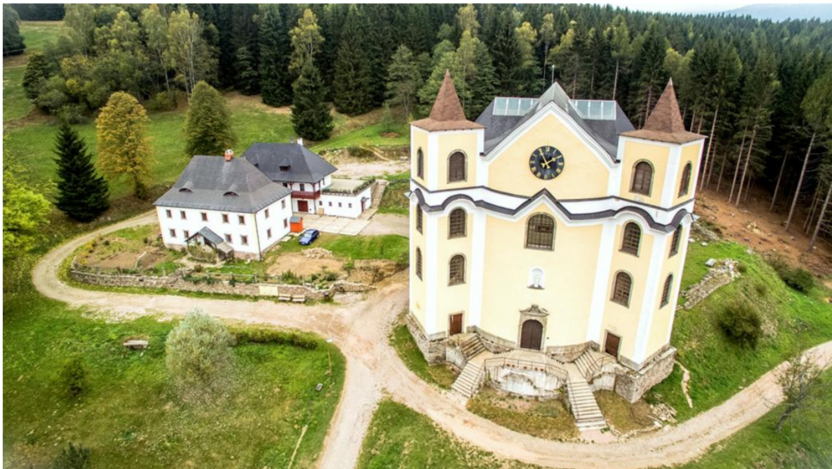
Obr. 14: Letecký pohled na kostel s farou
