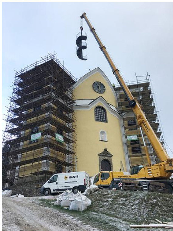
Obr. 39: Instalace točitého schodiště do věží (22. listopadu 2018)
