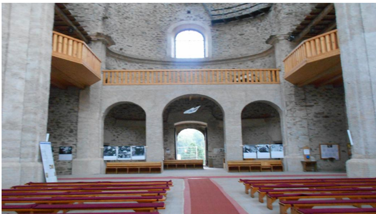
Obr. 28: Pohled na vstupní část kostela s kůrem
