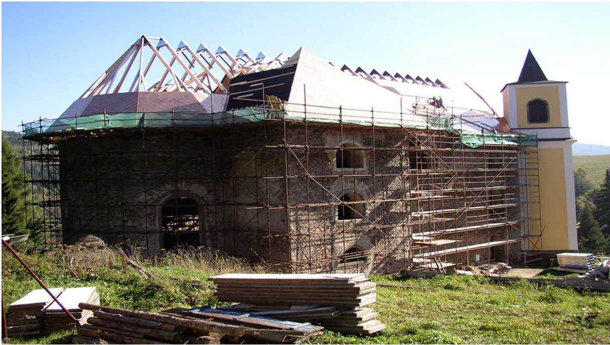
Obr. 13: Výstavba nové skleněné střechy v letech 2006-2008
