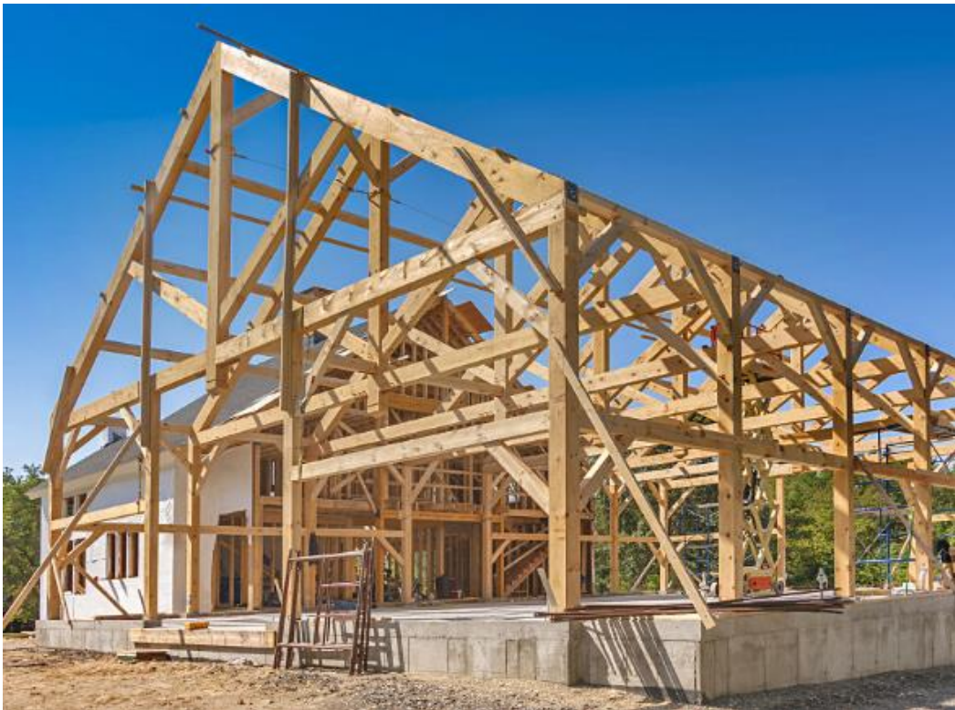
Obrázek 5: Konstrukce těžkého dřevěného skeletu (ESTAV, 2016)
