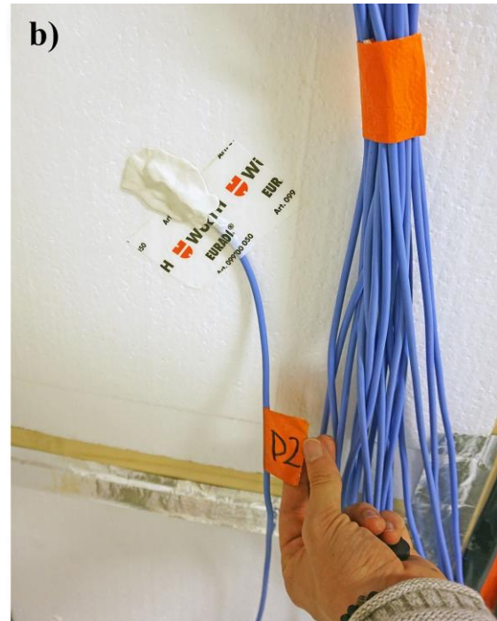
Příloha 5: (a) Instalace izolačního rámečku z expandovaného polystyrenu po obvodu panelu, (b) instalace teplotního čidla pomocí tmelu a lepicí pásky
