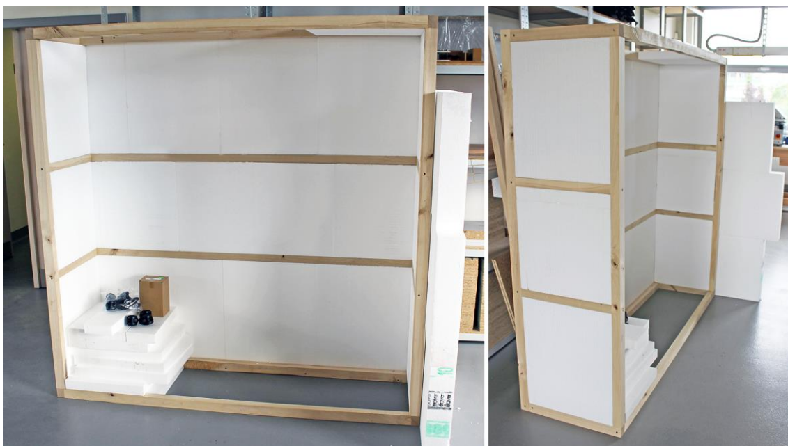
Příloha 3: Výroba konstrukce teplé skříně ve fakultní dílně
