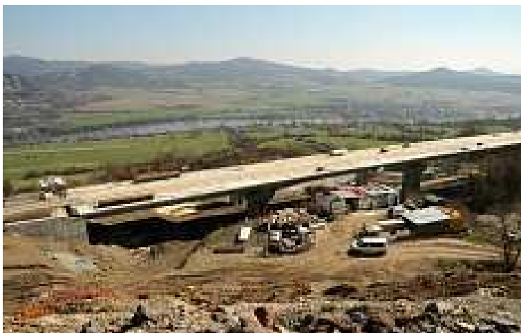
Foto č. 1: Výstavba D8 v CHKO České středohoří
