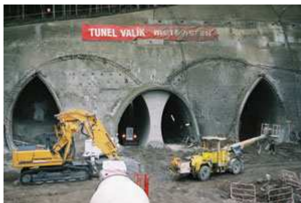
Foto č. 8: Ražba tunelu Valík
