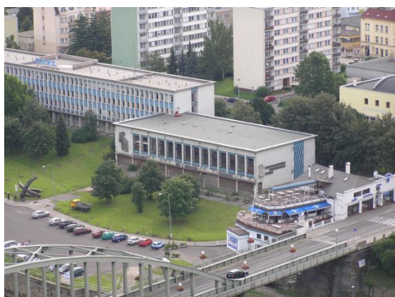
Obrázek 2: Bývalá budova Atlantiku
