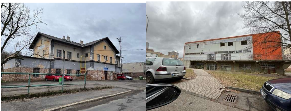
Obrázek 38, 39 - bývalé nádraží (budova se zbourá, již probíhá stavba celého komplexu nové nádraží) a bývalý obchodní dům (v návrhu na domov pro seniory)
