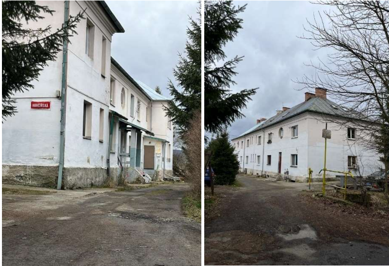
Obr. 34, 35 ul. Hrnčířská (kapitola 11.3.4)
