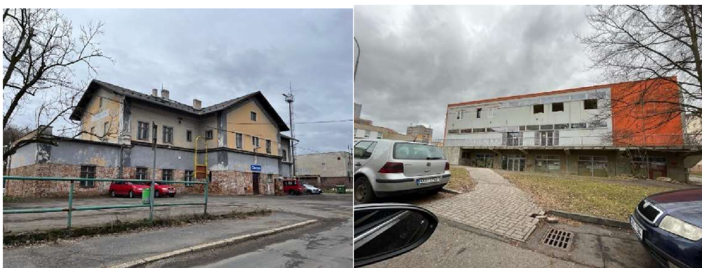
Obrázek 38, 39 - bývalé nádraží (budova se zbourá, již probíhá stavba celého komplexu nové nádraží) a bývalý obchodní dům (v návrhu na domov pro seniory)
