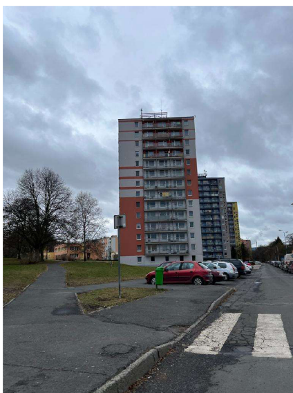
Obr. 43 – věžové domy ul. Smetanova (kapitola 11.3.2)
