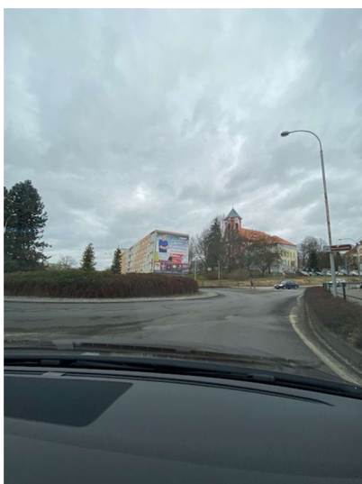
Obr. 44 – příjezd ke Kostelu sv. Vavřince (před ním panelové domy)
