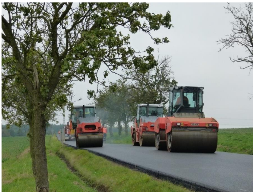
Obrázok č. 29: Rekonštrukcia cesty II/227 v roku 2016
