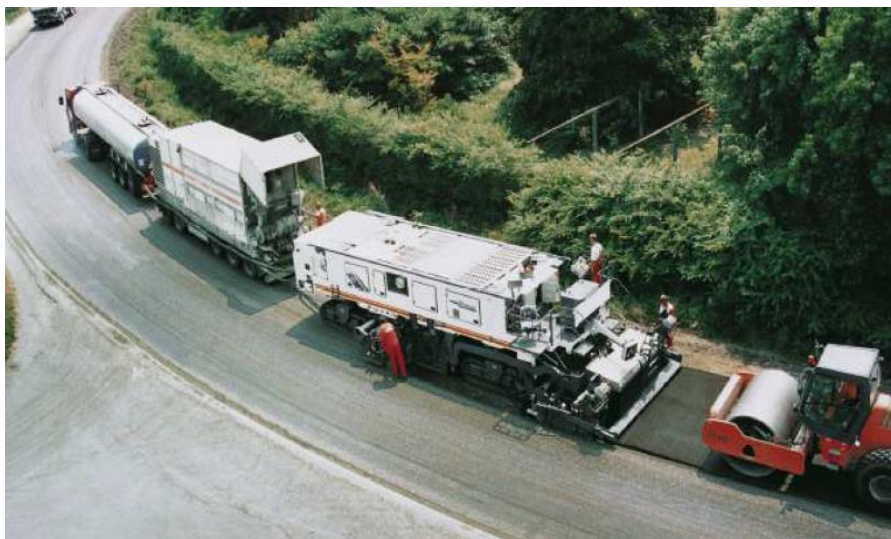
Obrázok č. 5: Zostava strojov používaných pre recykláciu za studena [7]
