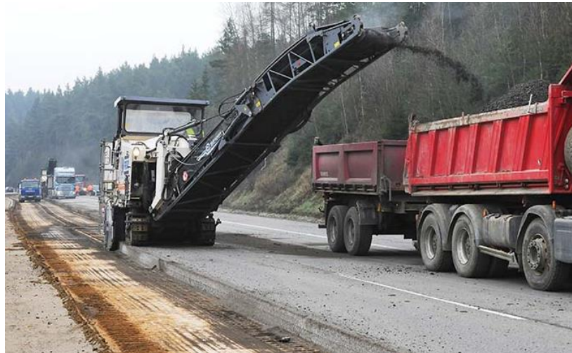
Obrázok č. 19: Frézovanie konštrukcie vozovky [12]
