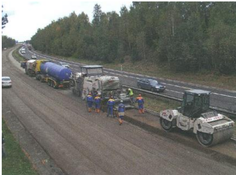
Obrázok č. 1: Recyklácia na mieste s použitím recyklačnej frézy [5]
