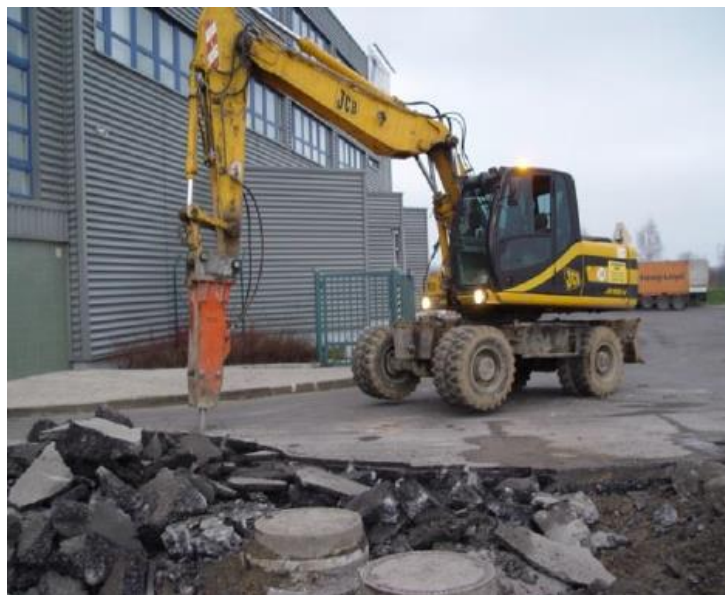
Obrázok č. 18: Búranie konštrukcie vozovky vo forme krýh [3]
