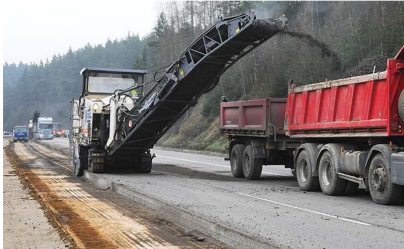
Obrázok č. 19: Frézovanie konštrukcie vozovky [12]
