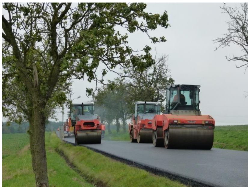
Obrázok č. 29: Rekonštrukcia cesty II/227 v roku 2016
