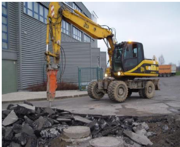
Obrázok č. 18: Búranie konštrukcie vozovky vo forme krých [3]
